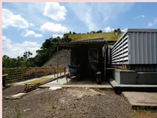
Foto 5-4. Vista geral da área externa da casa de força da PCH Cantú 2.
