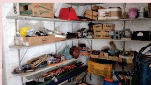
Foto 5-27. Vista de uma das prateleiras na sala de operação da PCH, indicando o armazenamento de produtos perigosos e equipamentos.
