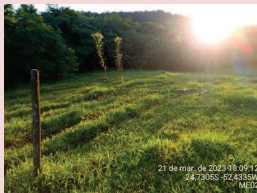
Foto 5-18. Vista de cercamento tombado na margem esquerda do reservatório onde pratica-se a criação de gado. Na foto, apenas um mourão erguido.
