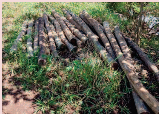
Foto 5-9. Mourões utilizados no cercamento da APP em processo erosivo na M.E. do reservatório.
