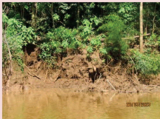
Foto 5-1. Vista de um trecho de APP com deslizamento de talude na M.E. do reservatório.
