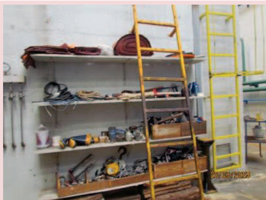
Foto 5-29. Vista de uma das prateleiras próximas de uma das Unidades Geradoras (UG2) da PCH.
