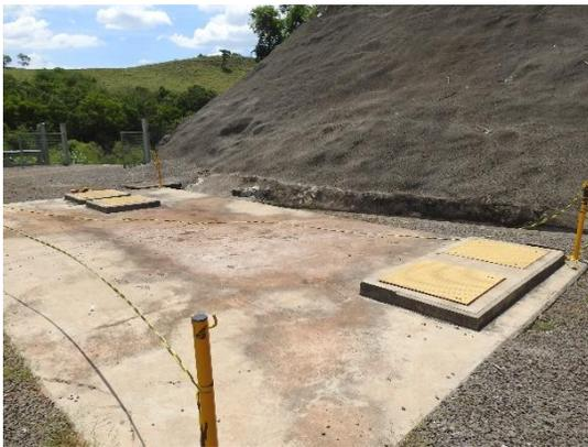
Foto 5-39. Sistema separador água e óleo (Caixa SAO) na área externa da casa de força da PCH Cantú 2.
