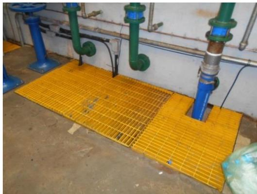
Foto 5-41. Grade com acesso para a caixa SAO na área interna da casa de força da PCH Cantú 2.
