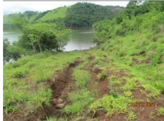
Foto 5-58. Vista parcial da erosão próximo da via carroçável construída na ME do reservatório. Nota-se a ocupação por gramíneas.
