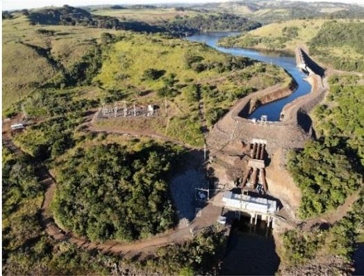
Foto 6-1. Vista aérea da casa de força e da alça de vazão reduzida da PCH Cantú 2.
