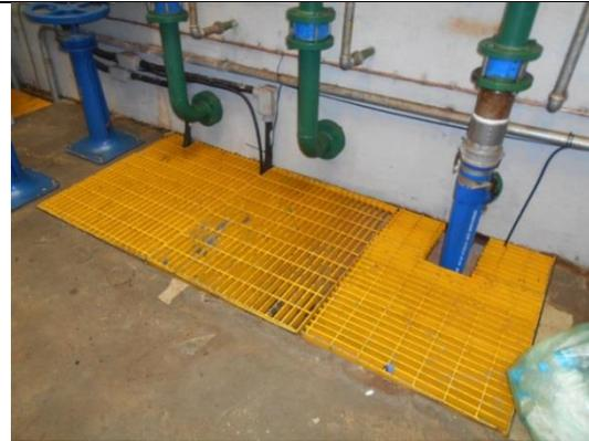
Foto 6-30. Grade com acesso para a caixa SAO na área interna da casa de força da PCH Cantú 2.
