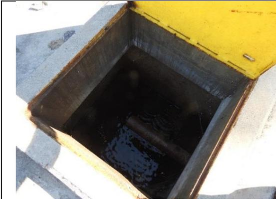
Foto 6-29. Vista interna da caixa SAO na área externa da PCH Cantú 2.
