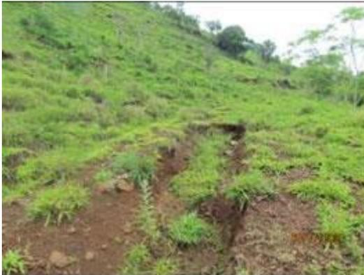
Foto 5-57. Vista parcial da erosão próximo da via carroçável construída na ME do reservatório. Nota-se a ocupação por gramíneas.
