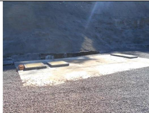
Foto 6-28. Sistema separador água e óleo (Caixa SAO) na área externa da casa de força da PCH Cantú 2.
