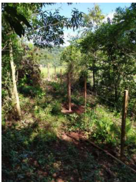
Figura 2.3.4.27 – Recuperação de cerca
