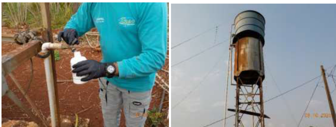
Figura 1.7 – Poço 01, próximo ao local Montante.
