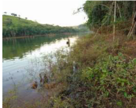
Figura 9.3.2.6 – Margem do reservatório (ME02, 22J 354651/7263307)
