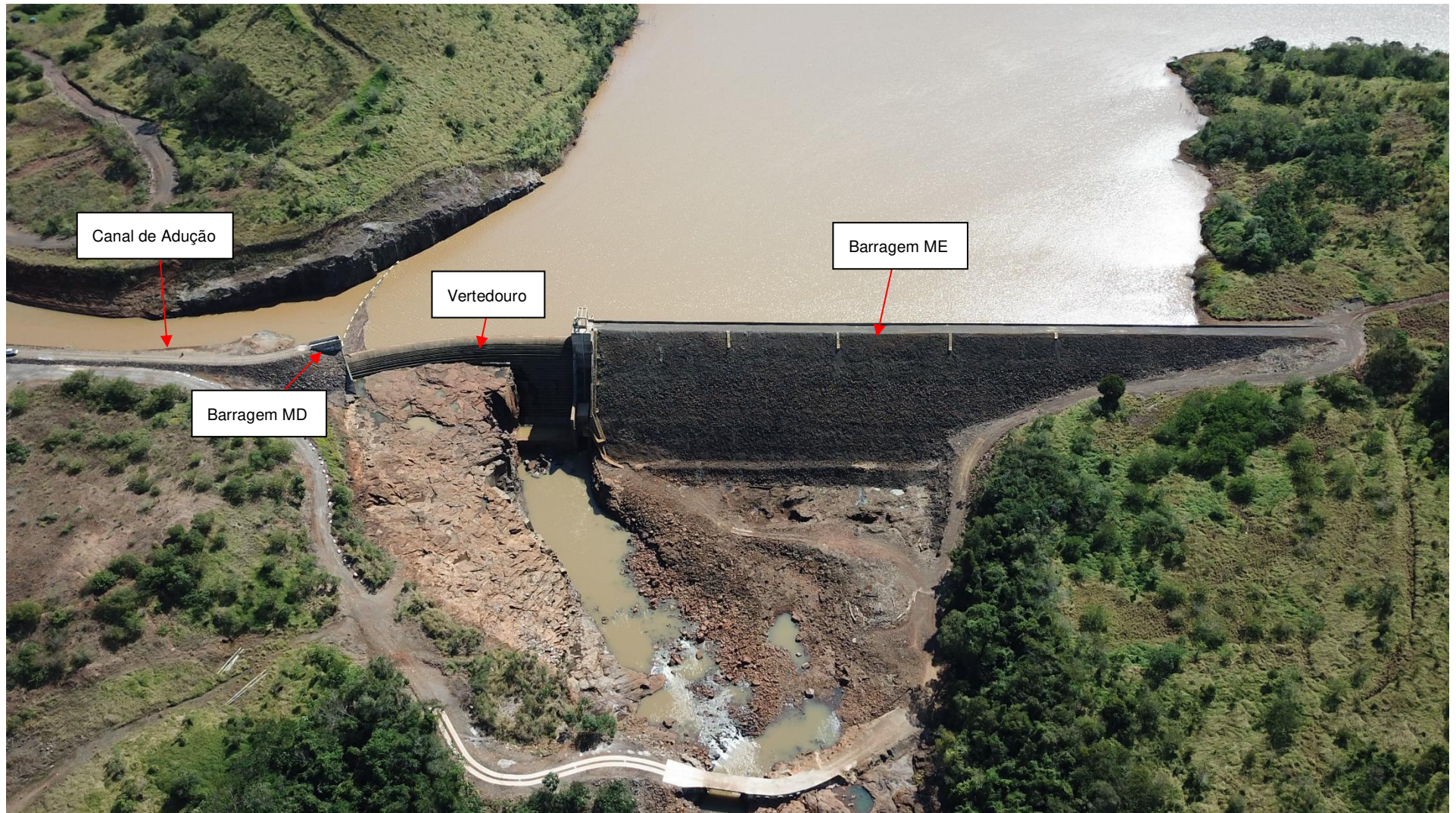
Figura 2 – Foto das estruturas civis da Montante – PCH Cantú 2
