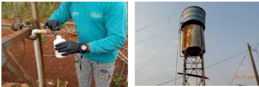
Figura 4.3.1.1 – Poço 01 próximo ao local Montante.
