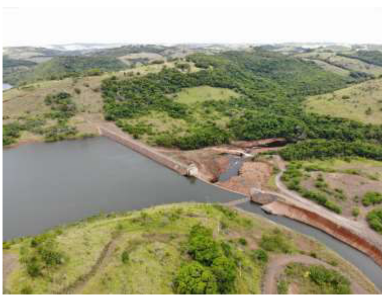
Figura 11.4.4 – Vistoria na Zona de Segurança e PRAD
