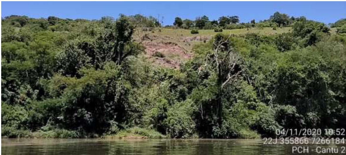
Figura 2.2.3.1 – Processo erosivo localizado na margem esquerda do reservatório artificial da PCH Cantu 2, sem processo de evolução.
