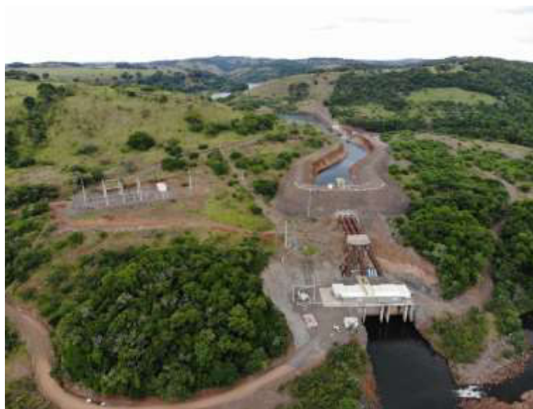
Figura 11.4.5 - Vistoria na Zona de Segurança e PRAD
