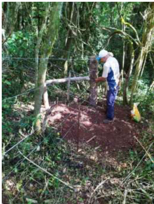
Figura 2.3.4.25 – Funcionário trabalhando na recuperação do cercamento
