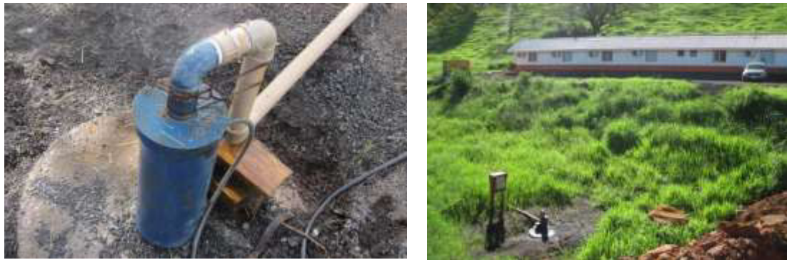
Figura 4.3.1.2 – Poço 02 no canteiro de obras da PCH Cantu 2.
