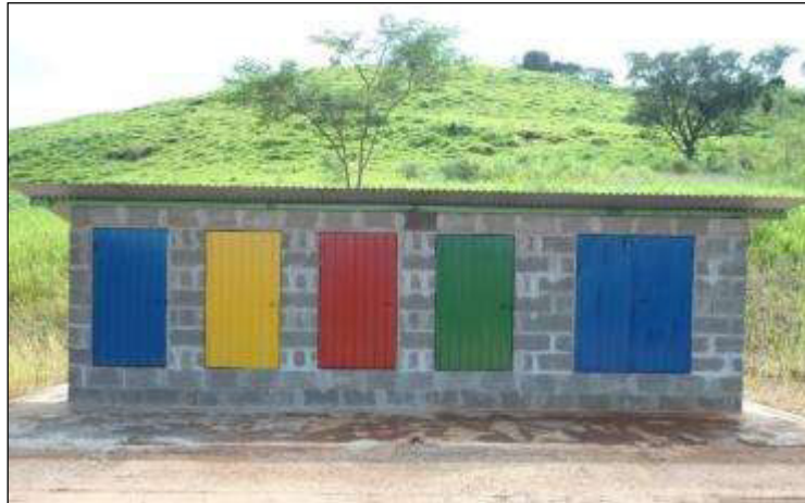
Figura 14.3.1 - Central de Resíduos Sólidos da PCH Cantu 2.
