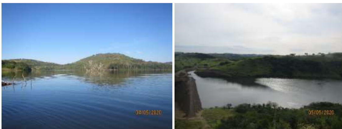
Figura 3 – Vista panorâmica do local de amostragem Reservatório ( RES ) na área de influência da PCH Cantu 2, rio Cantu.
