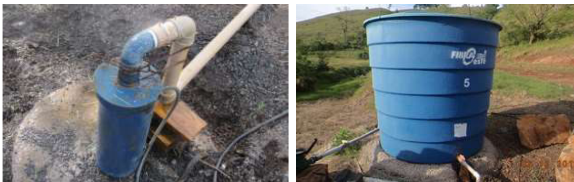
Figura 8 – Poço 02 no canteiro de obras da PCH Cantu 2.
