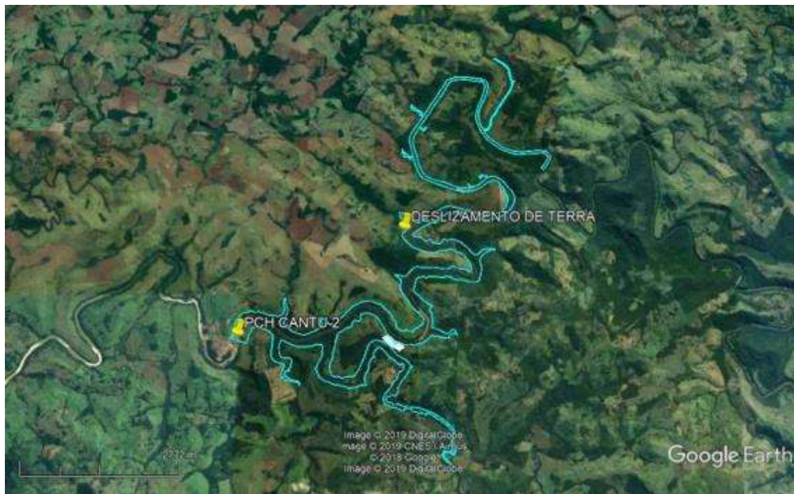
Figura 2.2.4.6 - Localização do foco de deslizamento de terra no reservatório da PCH Cantu 2, representado pela linha azul.
