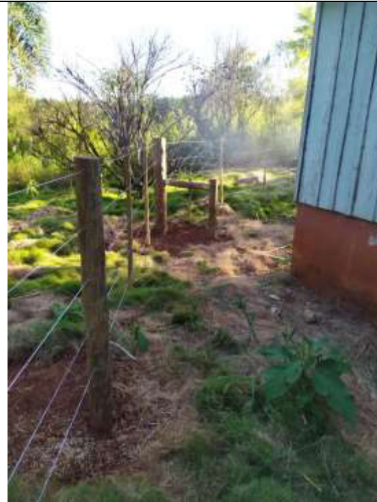
Figura 2.3.4.4 Cerca divisória separando estrutura da APP
