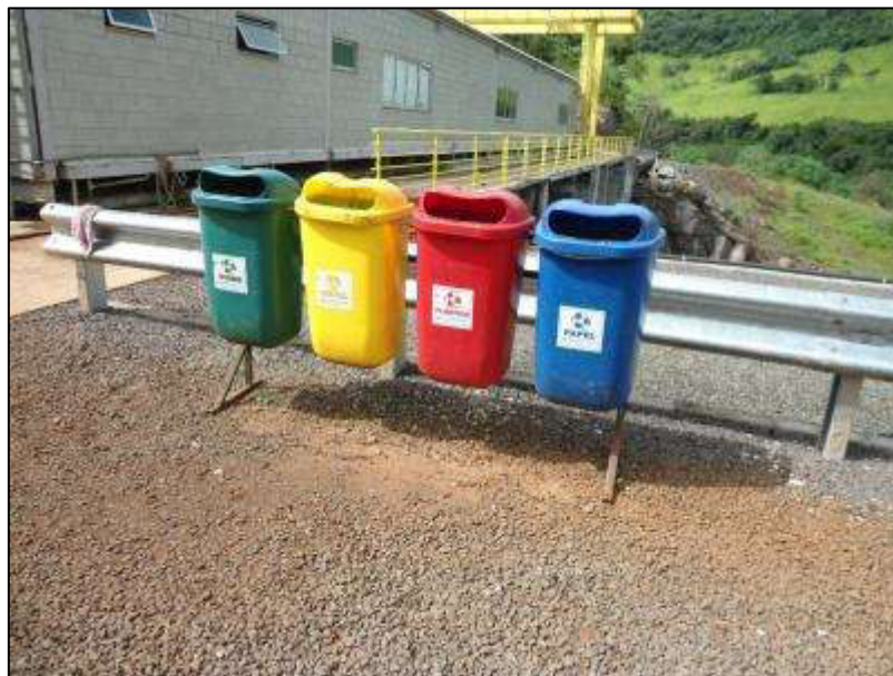
Figura 14.3.2 Coletores de resíduos recicláveis na PCH Cantu 2.
