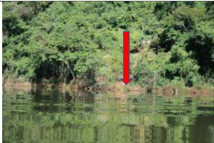
Figura 2.2.4.1 Visão da margem do reservatório com deslizamento. Seta vermelha indicando o local do deslizamento. Imagens registrada em abril de 2020
