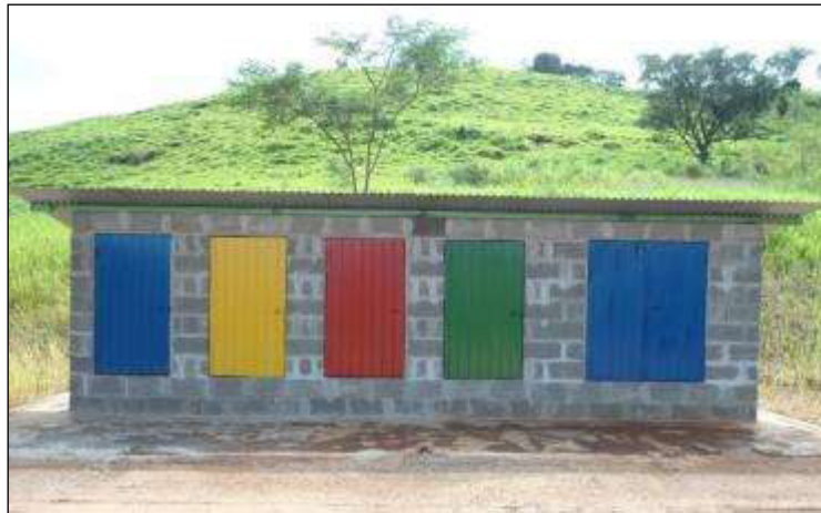
Figura 14.3.1 - Central de Resíduos Sólidos da PCH Cantu 2.
