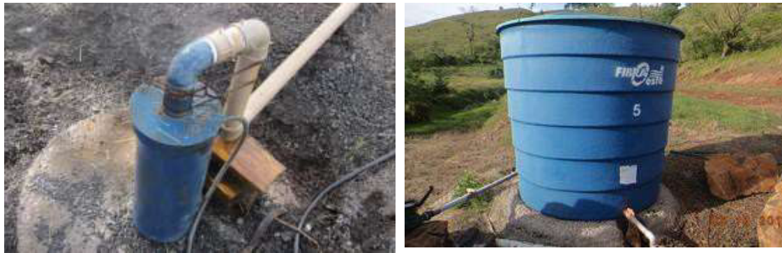
Figura 4.3.1.2 – Poço 02 no canteiro de obras da PCH Cantu 2.
