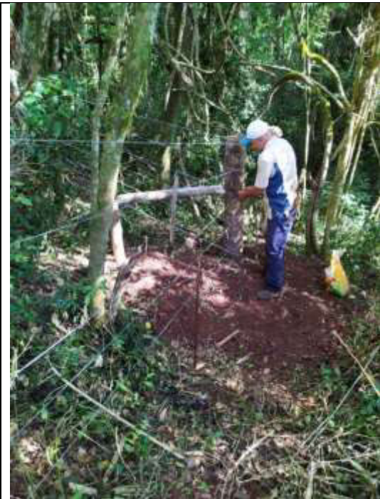
Figura 2.3.4.1 – Funcionário trabalhando na recuperação da cerca
