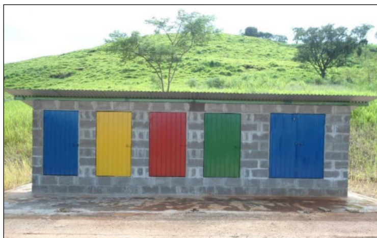
Figura 14.4.1 - Central de Resíduos Sólidos da PCH Cantu 2.
