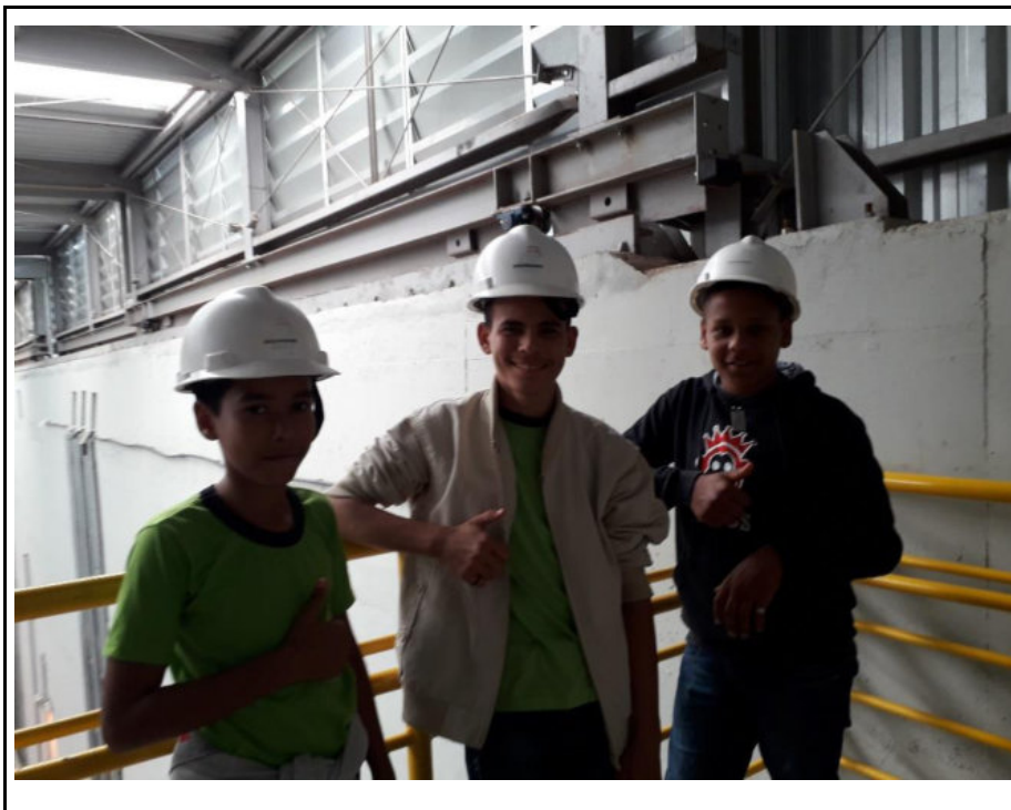
Alunos do Colégio Estadual do Campo Salles de Oliveira na casa de força da PCH Cantu 2.
