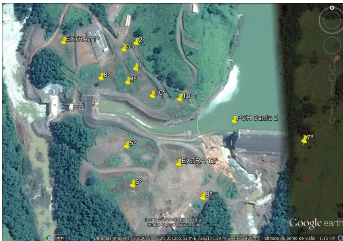
Figura 3.4.1: Canteiro de Obras com a localização das 12 áreas trabalhadas no PRAD.
