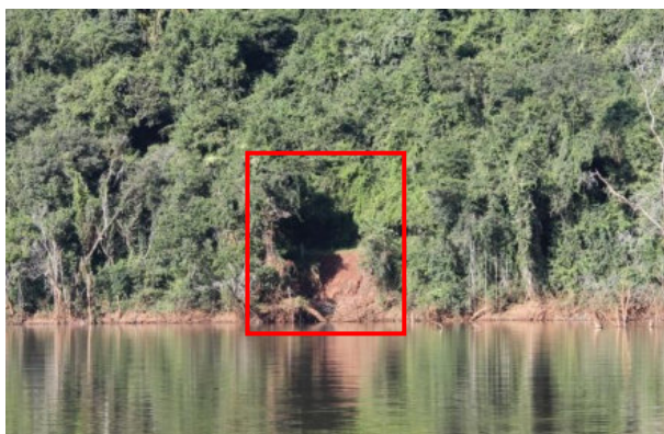
Figura 2.2.5.2 - Imagem do deslizamento de terra às margens do reservatório da PCH Cantu 2.
