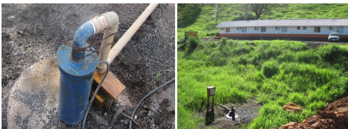
Figura 1.8 – Poço 02, no canteiro de obras da PCH Cantu 2.
