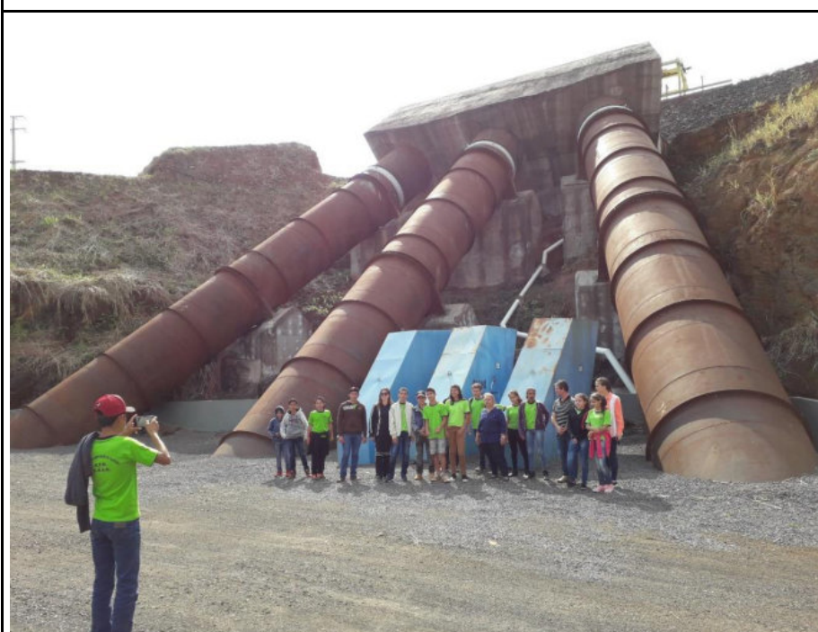
Alunos do Colégio Estadual do Campo Salles de Oliveira próximos aos condutos forçados da PCH Cantu 2.
