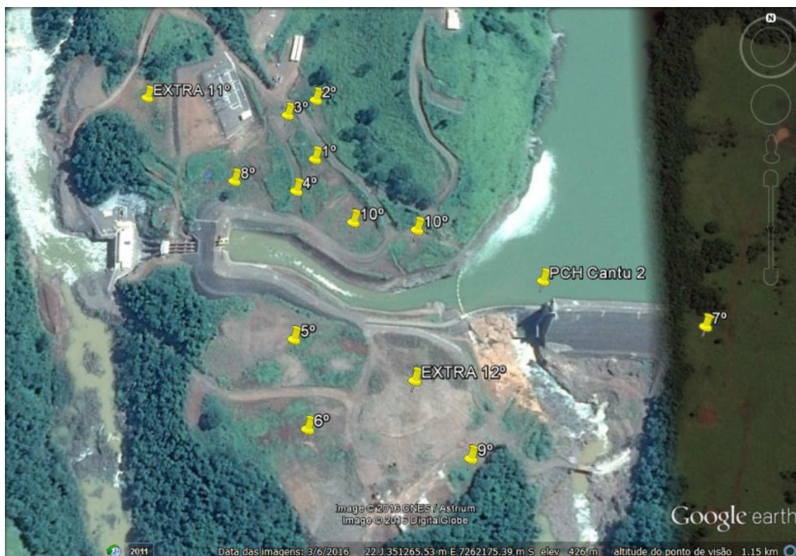
Figura 3.4.3: Canteiro de Obras com a localização das 12 áreas trabalhadas no PRAD.
