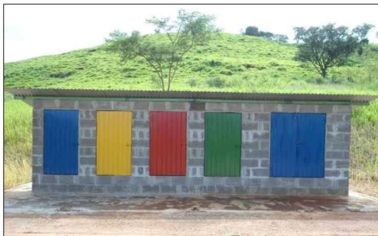
Figura 14.4.1 - Central de Resíduos Sólidos da PCH Cantu 2.
