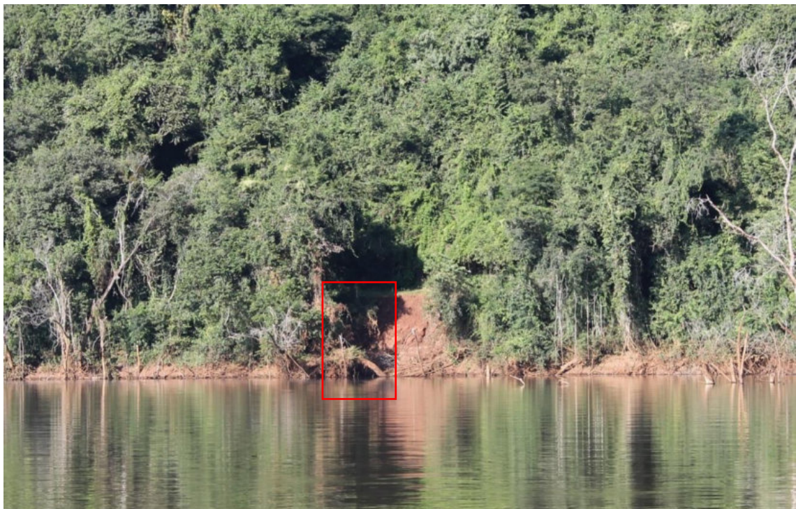
Figura 2.2.5.2: Imagem do deslizamento de terra às margens do reservatório da PCH Cantu 2.
