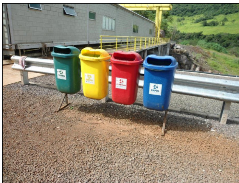
Figura 14.4.2 Coletores de resíduos recicláveis na PCH Cantu 2.
