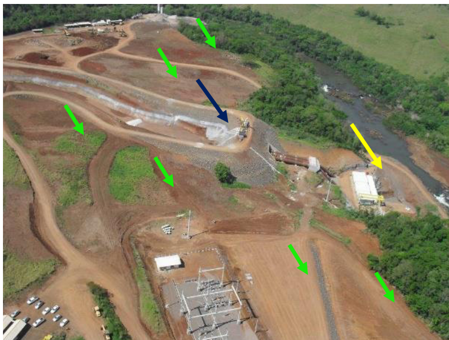
Figura 3.4.1: Imagem do final da instalação da PCH Cantu 2 em 2015. Seta azul: Canal de adução; Seta amarela: Casa de Força e Casa de Comando; Setas verdes: Locais em recuperação ambiental.
