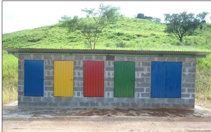
Figura 4.15.4.1 - Central de Resíduos Sólidos da PCH Cantu 2.
