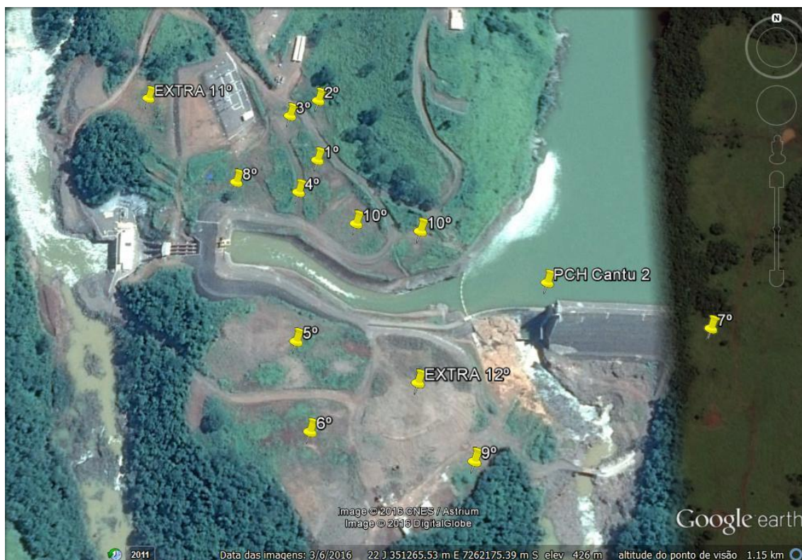
Figura 4.4.4.3 – Canteiro de Obras com a localização das 10 áreas trabalhadas no PRAD.
