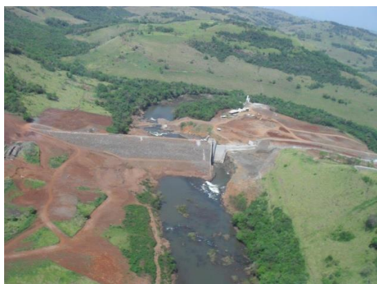
Figura 4.4.4.1 – Canteiro de Obras (fase final).
