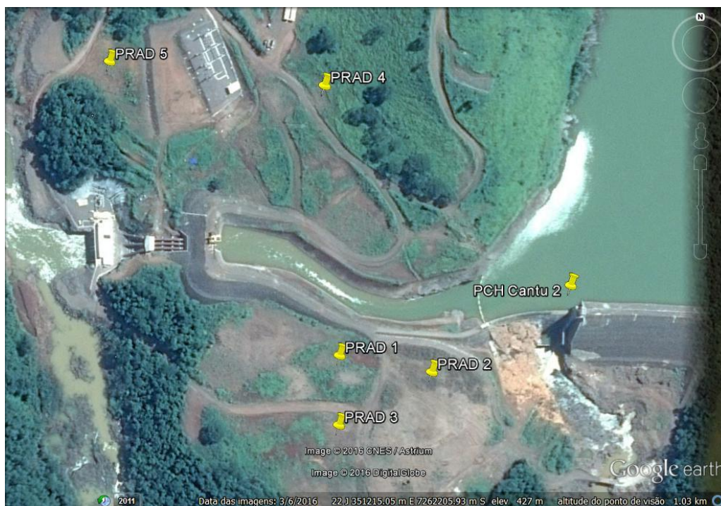
Figura 4.4.4.1.1 – Canteiro de Obras da PCH CANTU 2.
