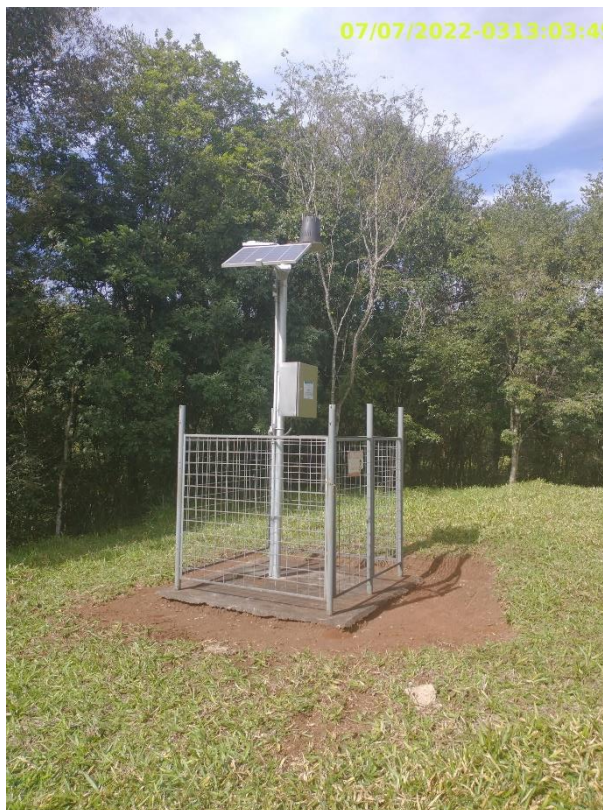
Estação Telemétrica Limpa (longe)
