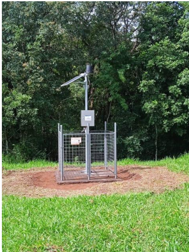
Estação Telemétrica Limpa (longe)
