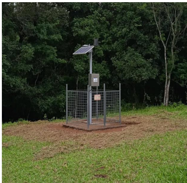
Estação Telemétrica Limpa (longe)
