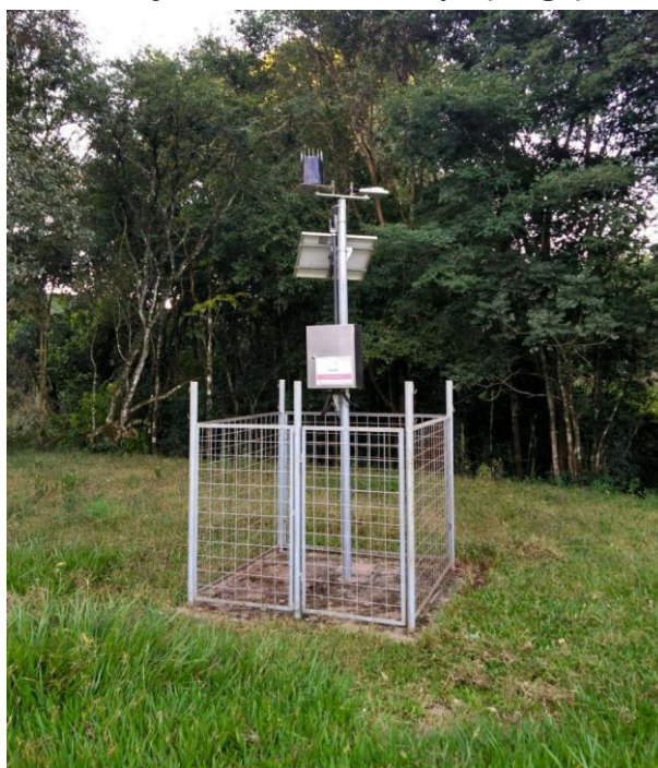
Estação Telemétrica Limpa (longe)
