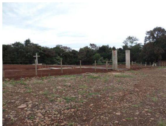
Figuras 6.1.3.3.11 - Obras de expansão do cemitério
