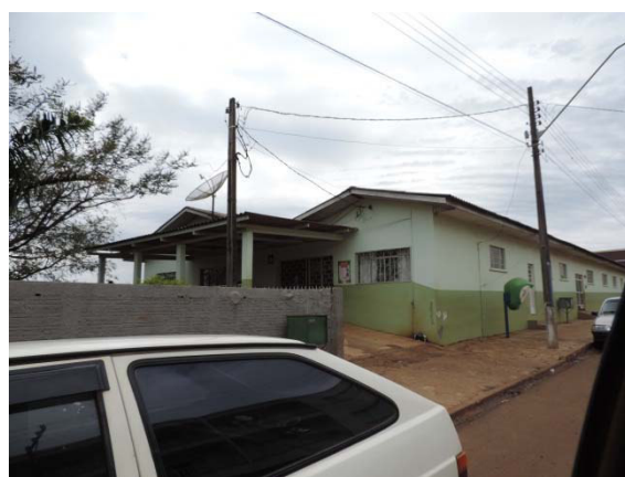
Figuras 6.3.1.4.18 - Entrada de Escola
