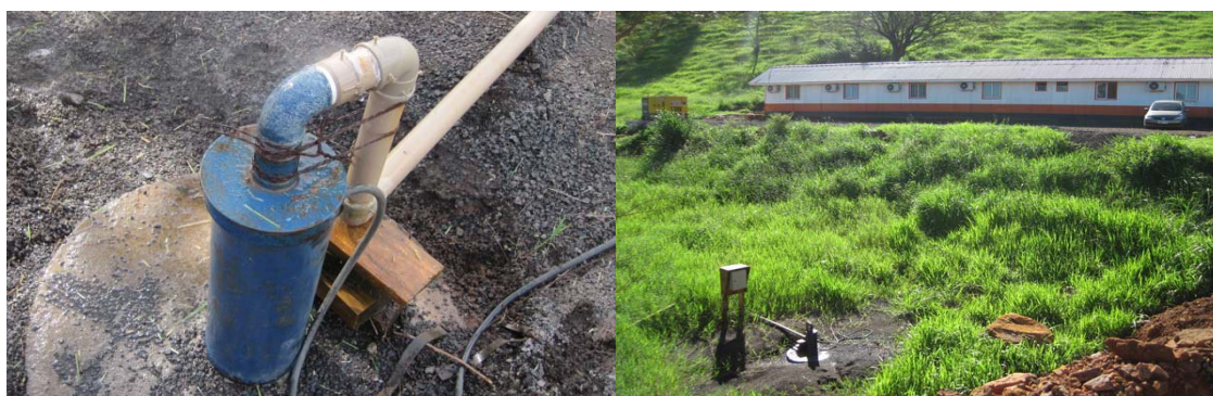
Figura 6.1.9.1.6– Poço 02 no canteiro de obras da PCH Cantu 2.
