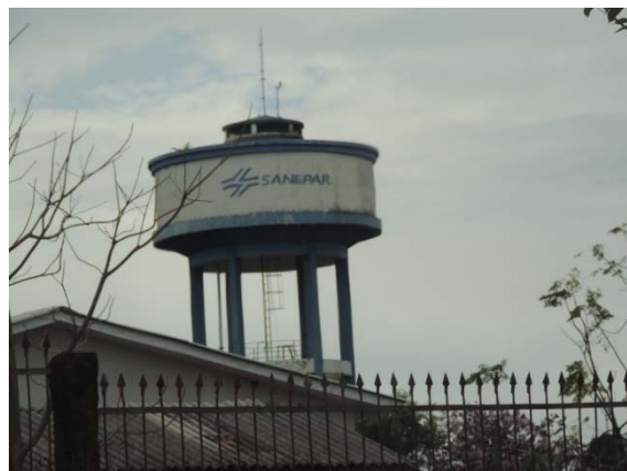
Figuras 6.3.1.4.20 - Caixa d'água de Abastecimento
