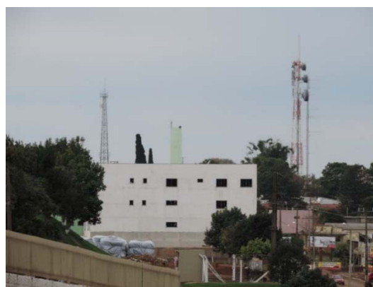
Figuras 6.3.1.4.6 - Torres de telecomunicações
