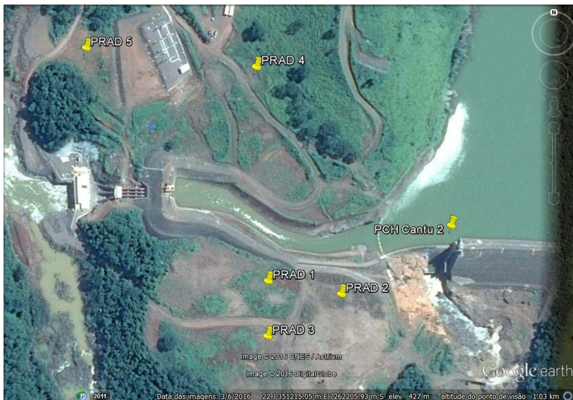
Figura 4.4.4.4 – Canteiro de Obras da PCH CANTU 2.
