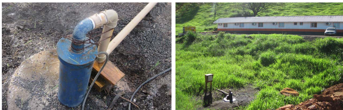
Figura 4.6.5.10 e 4.6.5.11 – Poço 02 no canteiro de obras da PCH Cantu 2.
