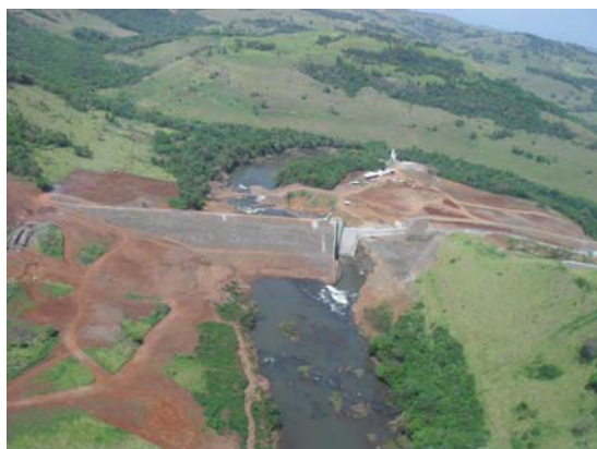
Figura 4.4.4.1 – Canteiro de Obras (fase final).
