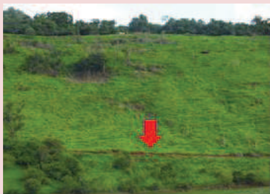
Foto 5-19. Vista parcial de uma antiga via carroçável construída na M.E. do reservatório, da propriedade João Maurício Virmond.
