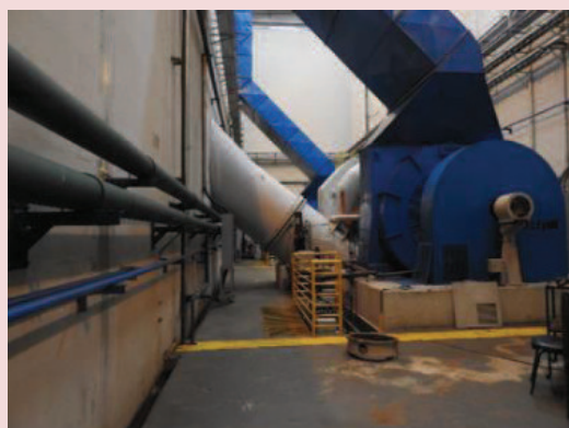
Foto 5-20. Vista das Unidades Geradoras (UG) da casa de força da PCH Cantú 2 organizadas.
