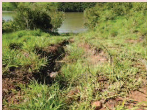
Foto 5-23. Vista parcial da erosão do tipo sulco evidenciando as dimensões desse processo.
