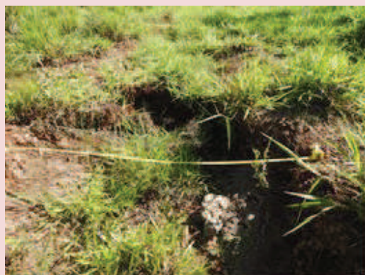
Foto 5-21. Vista parcial da erosão próxima da via carroçável construída na margem esquerda do reservatório, na propriedade J.M. Virmond.
