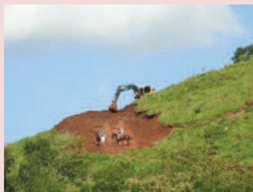
Foto 5-2. Vista aproximada da maquinaria trabalhando na abertura de leito carroçável à M.E. do reservatório.
