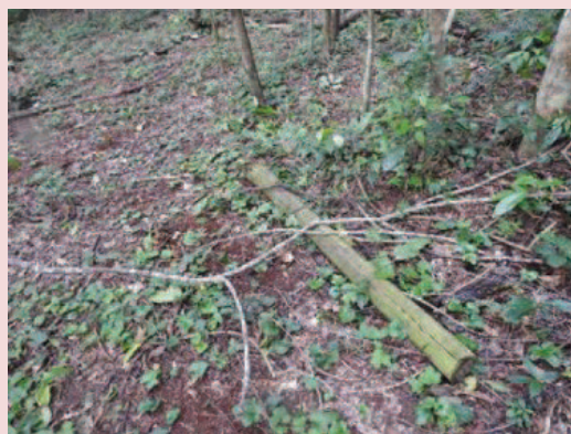
Foto 5-32. Vista da cerca tombada no interior da parcela 1ME, permitindo o livre acesso pelo gado.
