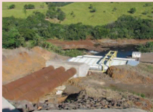
Foto 5-2. Vista aproximada da casa de força da PCH Cantú 2.
