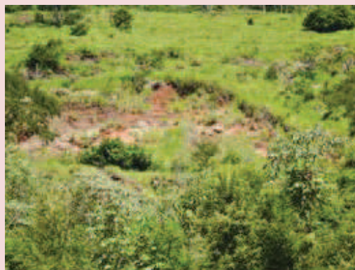
Foto 5-14. Vista ampliada do talude que desmoronou e que se encontra em recuperação natural.
