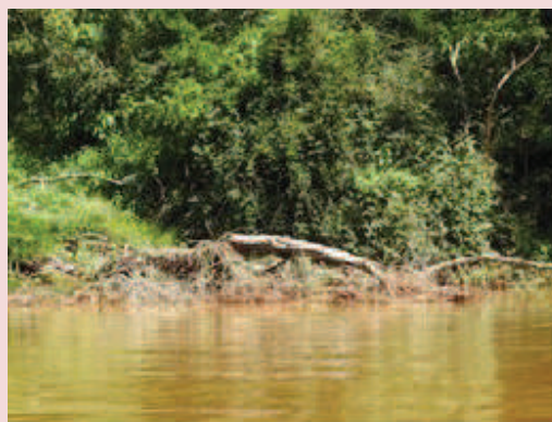
Foto 5-16. Vista do restolho de troncos e galhos na área de assoreamento do antigo desmoronamento na M.E. do reservatório.
