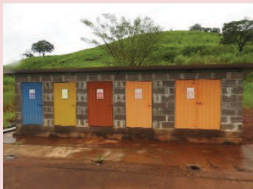
Foto 5-11. Compartimentos para transbordo final de resíduos das classes I e II. Situa-se próximo da portaria e do escritório da PCH Cantú 2.
