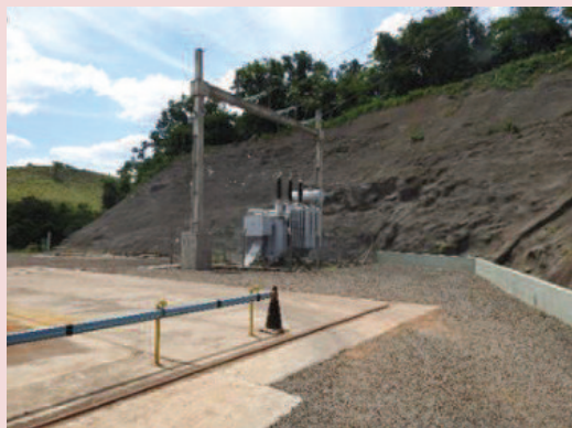
Foto 5-3. Vista geral da área externa da casa de força da PCH Cantú 2.
