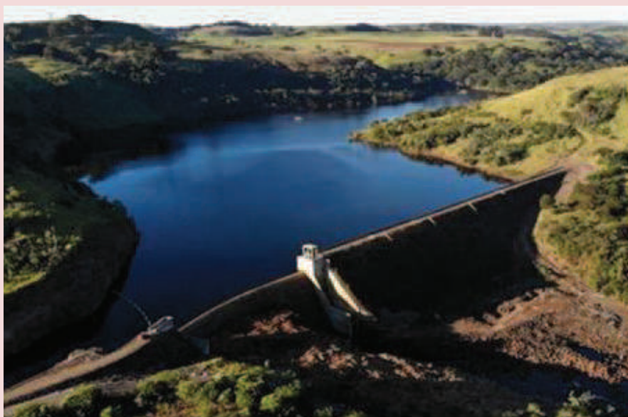
Foto 5-3. Vista aérea do Barramento da PCH Cantú 2, Rio Cantú, Paraná.
