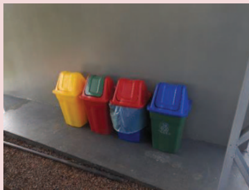
Foto 5-10. Coletores para diferentes tipos de resíduos Classe II na área externa do escritório da PCH Cantú 2.
