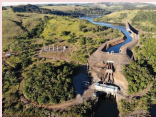
Foto 5-1. Vista aérea da casa de força da PCH Cantú 2.
