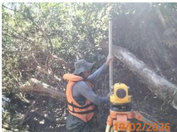
Levantamento da seção transversal
