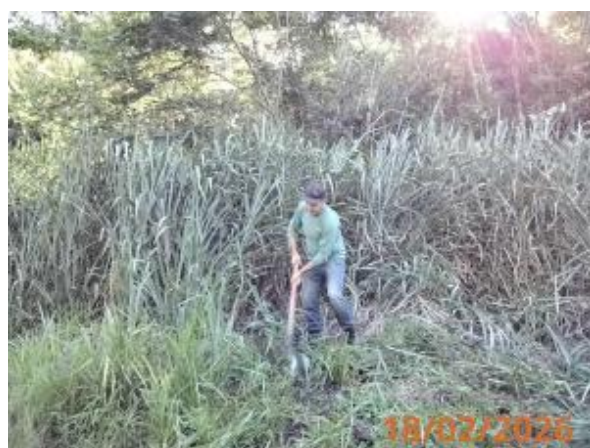
Limpeza da vegetação na área da estação
