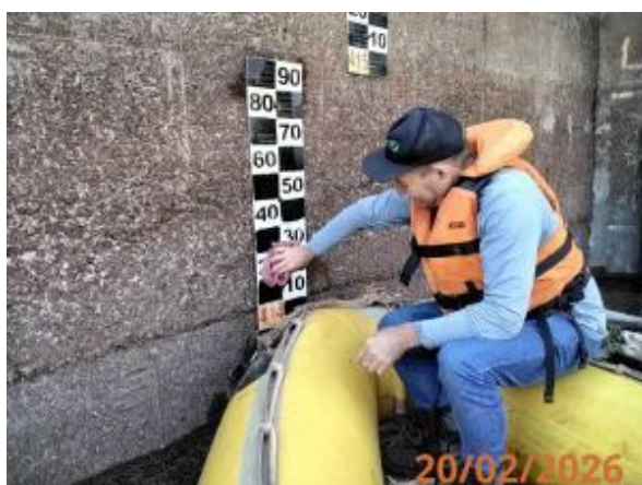
Limpeza/desassoreamento de réguas
