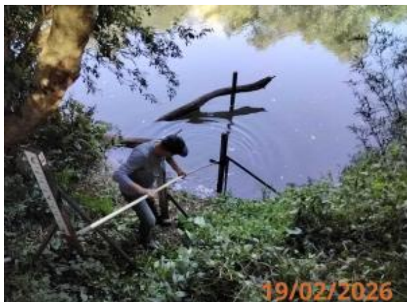
Limpeza e desassoreamento de réguas
