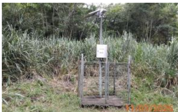
Vista Geral da estação
