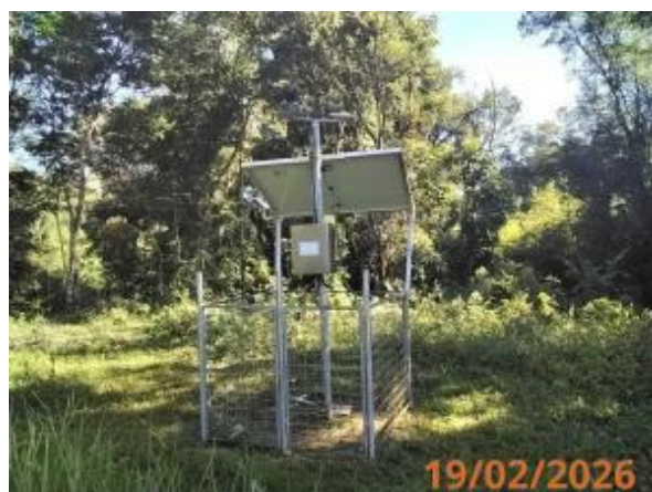
Vista geral da estação
