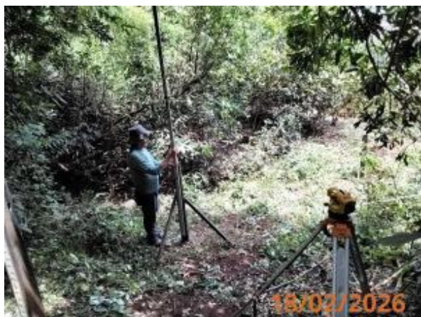
Nivelamento de réguas
