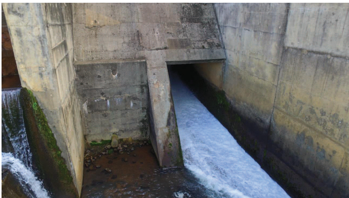
Figura 15 – Galeria de desvio com um dos vãos tamponado
