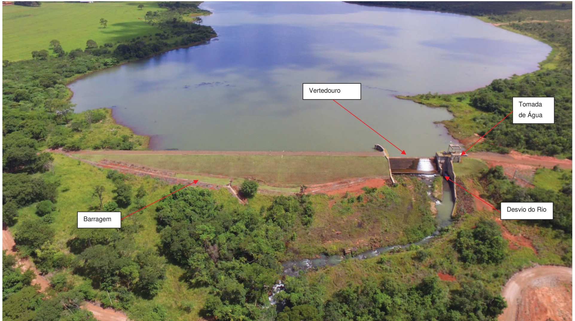
Figura 5 – Vista das estruturas do barramento da PCH Planalto
