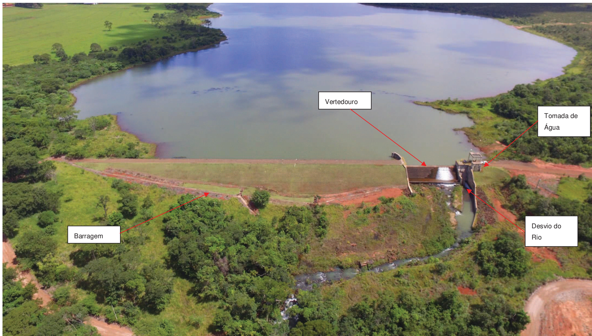
Figura 3 – Barragem, Vertedouro e Tomada de Água
