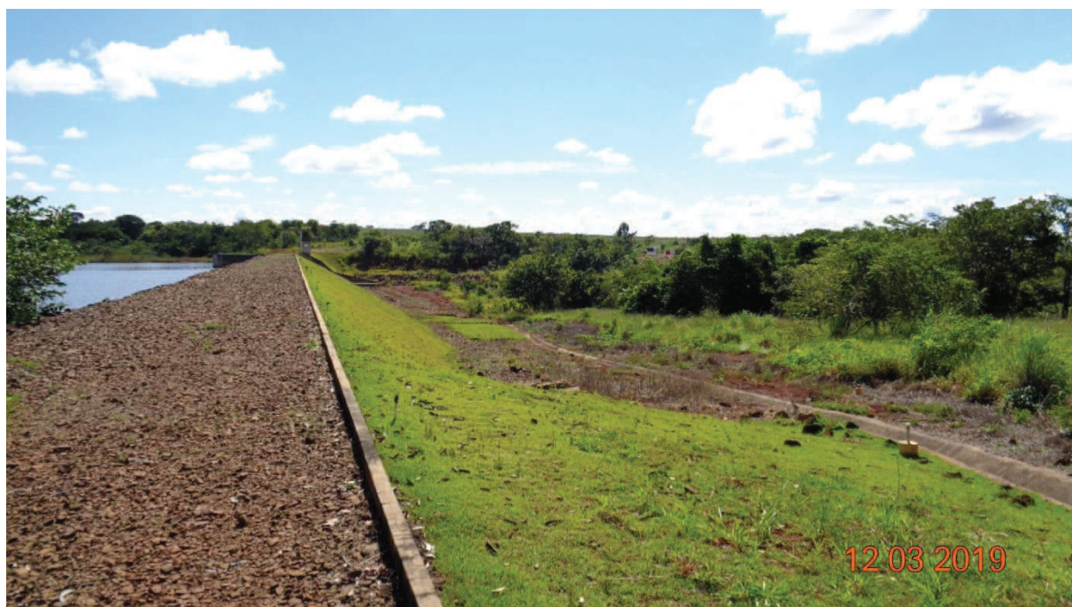
Figura 7 – Vista da barragem MD com crista e proteção vegetal em boas condições de manutenção
