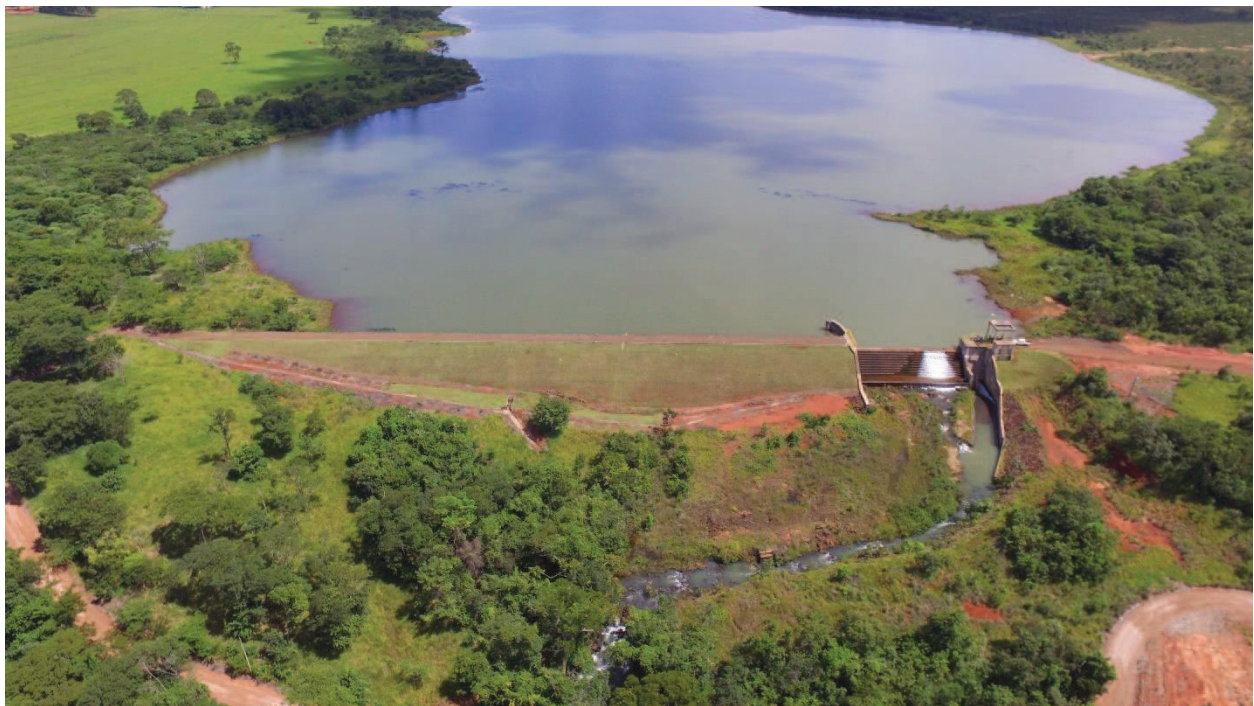
Figura 21 – Vista Geral do barramento
