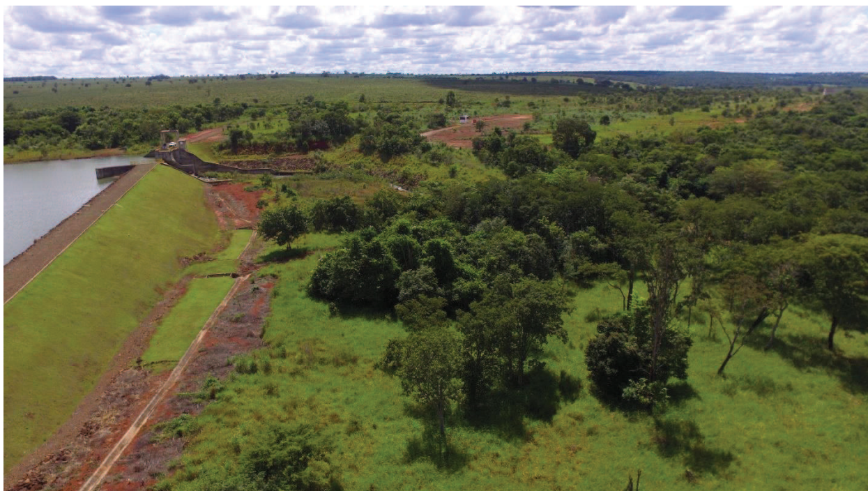
Figura 23 – Vista Geral da Barragem Ombreira Direita – Talude jusante
