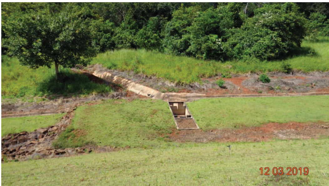
Figura 10 – Vista do talude de jusante da barragem e do medidor de vazão 2 sem água
