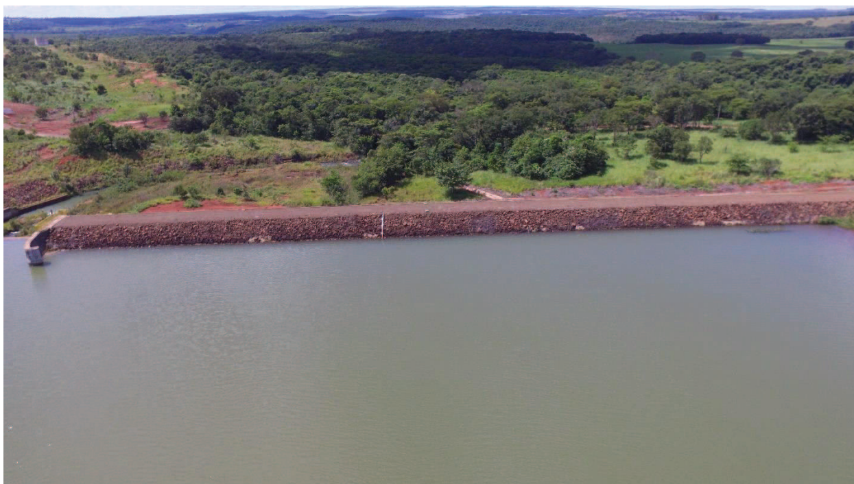
Figura 22 – Vista Geral da Barragem Ombreira Direita – Talude montante
