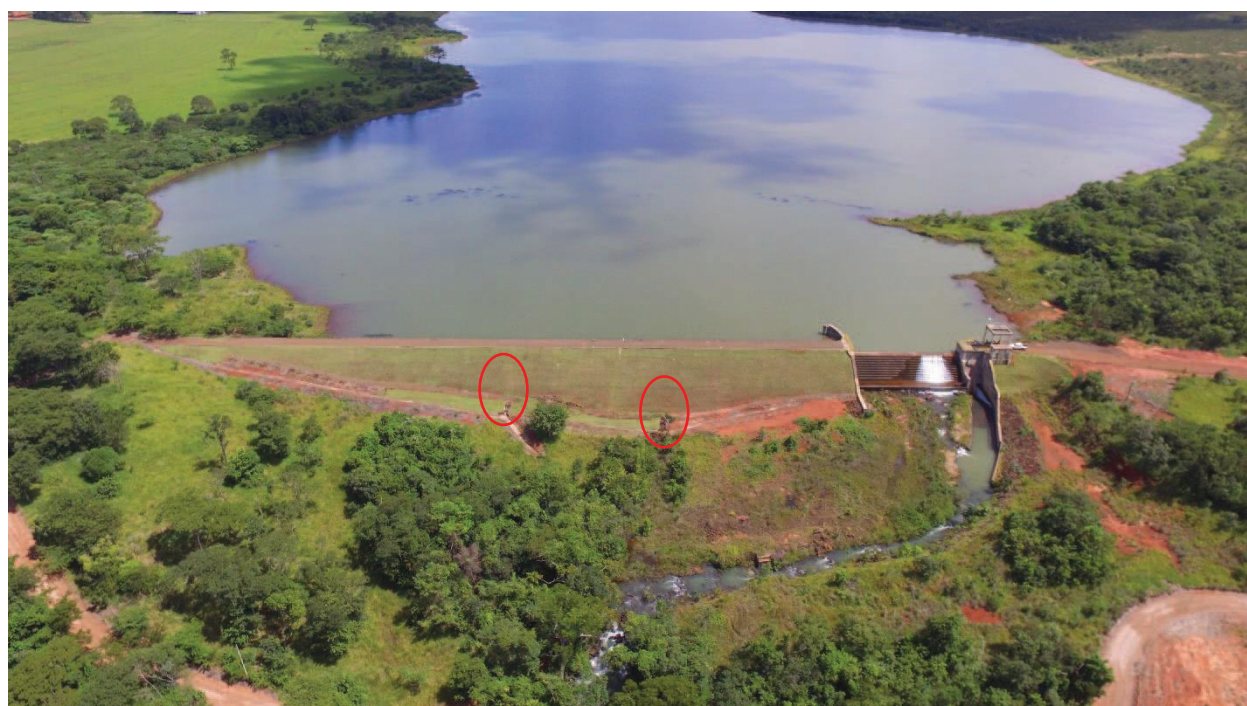
Figura 8 – Vista do talude de jusante da barragem com destaque aos medidores de vazão
