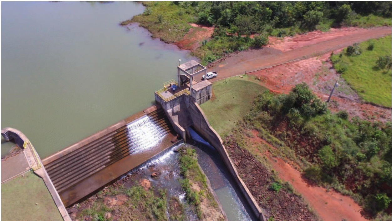
Figura 24 – Vista Geral do Vertedouro e margem esquerda da Barragem
