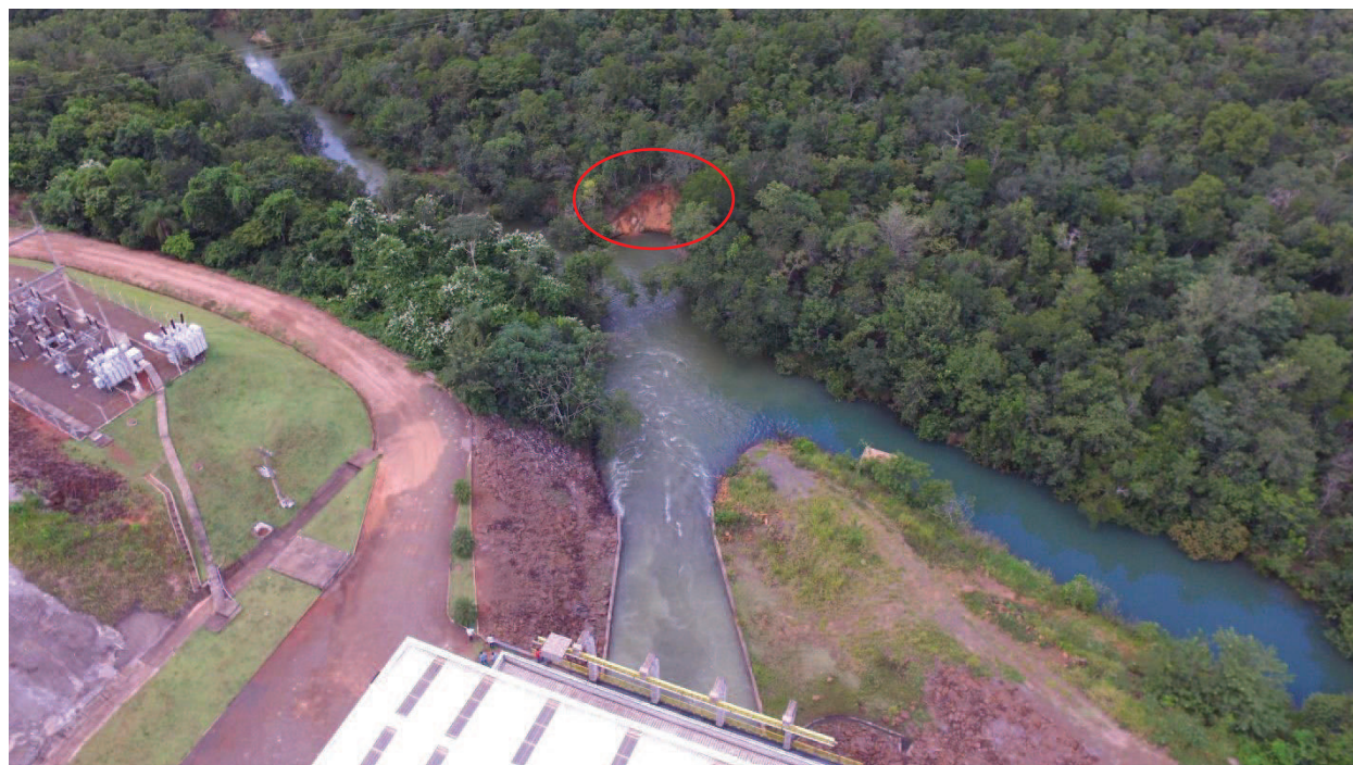
Figura 32 – Vista do canal de fuga da PCH Planalto
