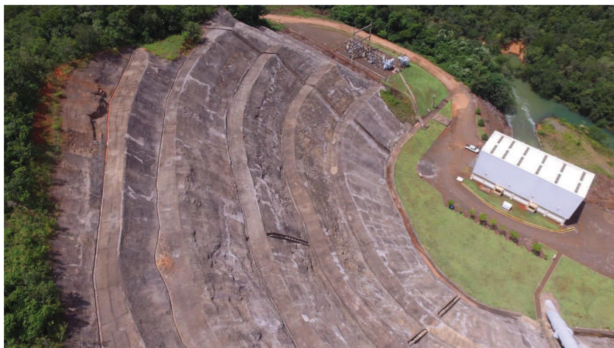
Figura 30 – Pátio externo a montante da casa de força
