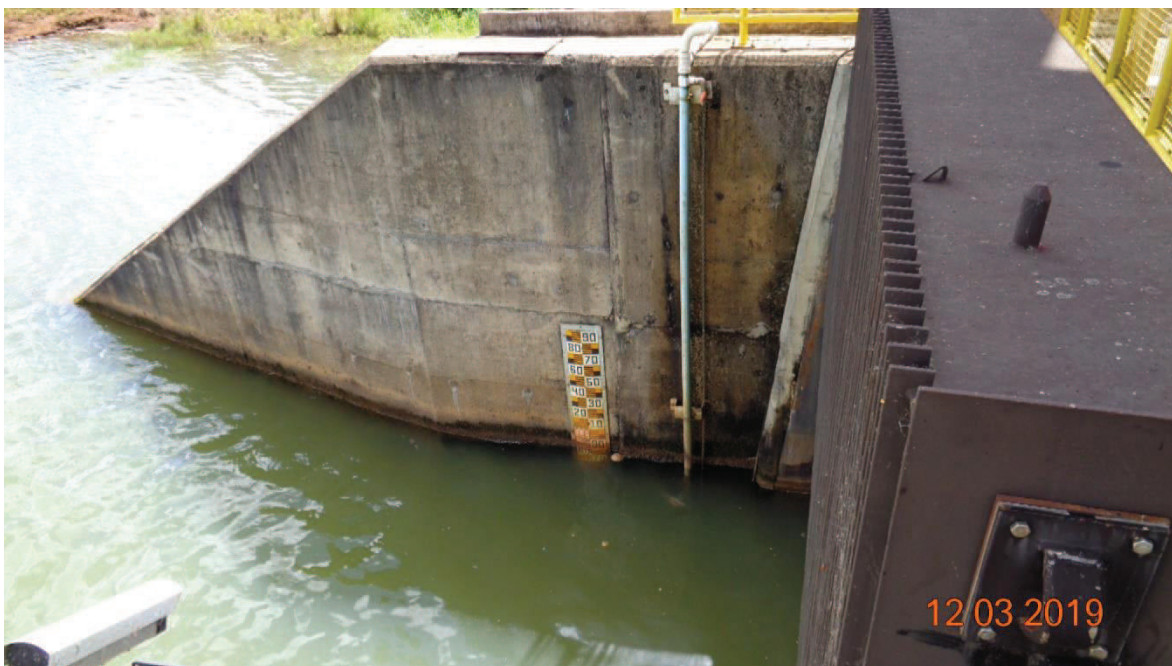
Figura 17 – Vista da estrutura da tomada de água na lateral esquerda
