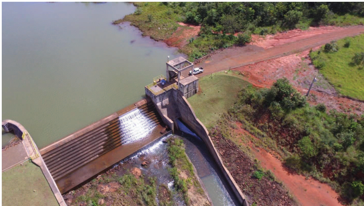
Figura 12 – Vista geral do Vertedouro, Desvio do rio e tomada de água
