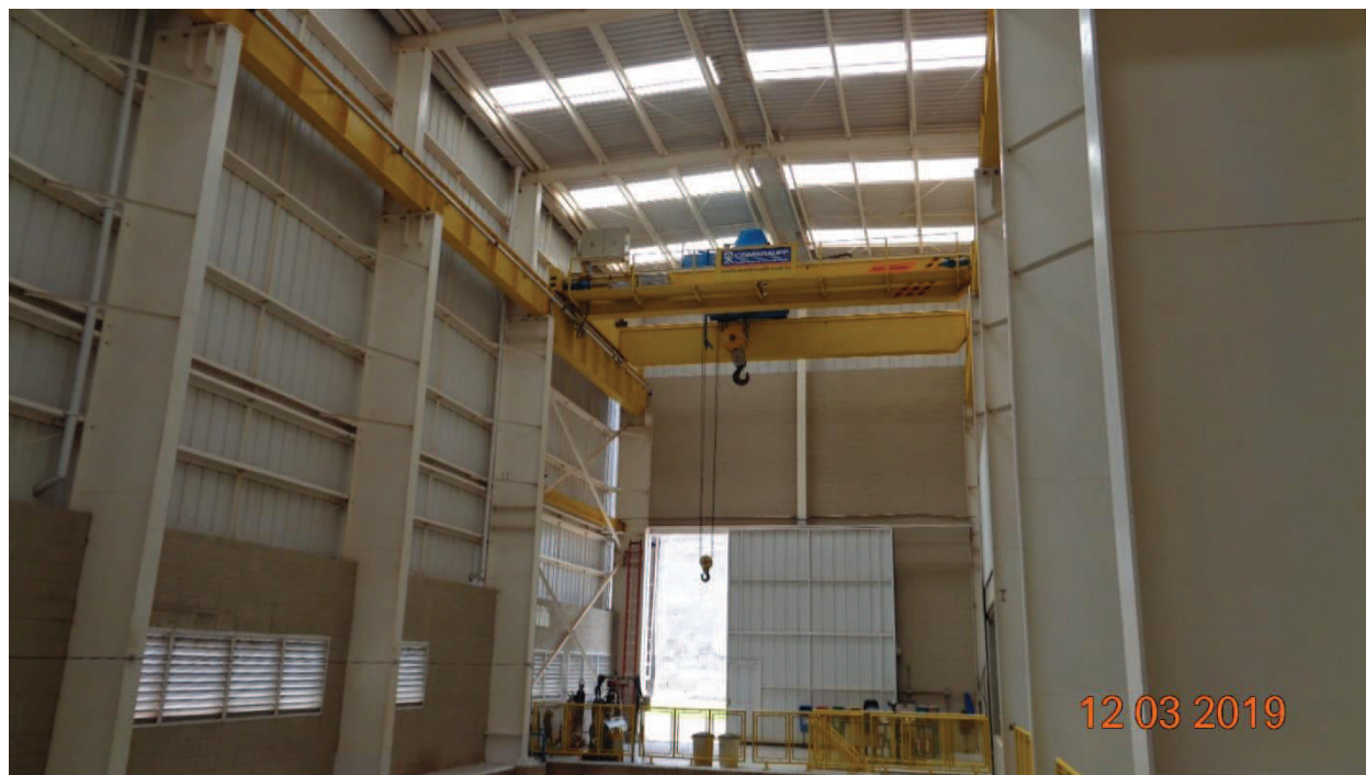
Figura 29 – Área de montagem, ponte rolante e estrutura metálica da casa de força
