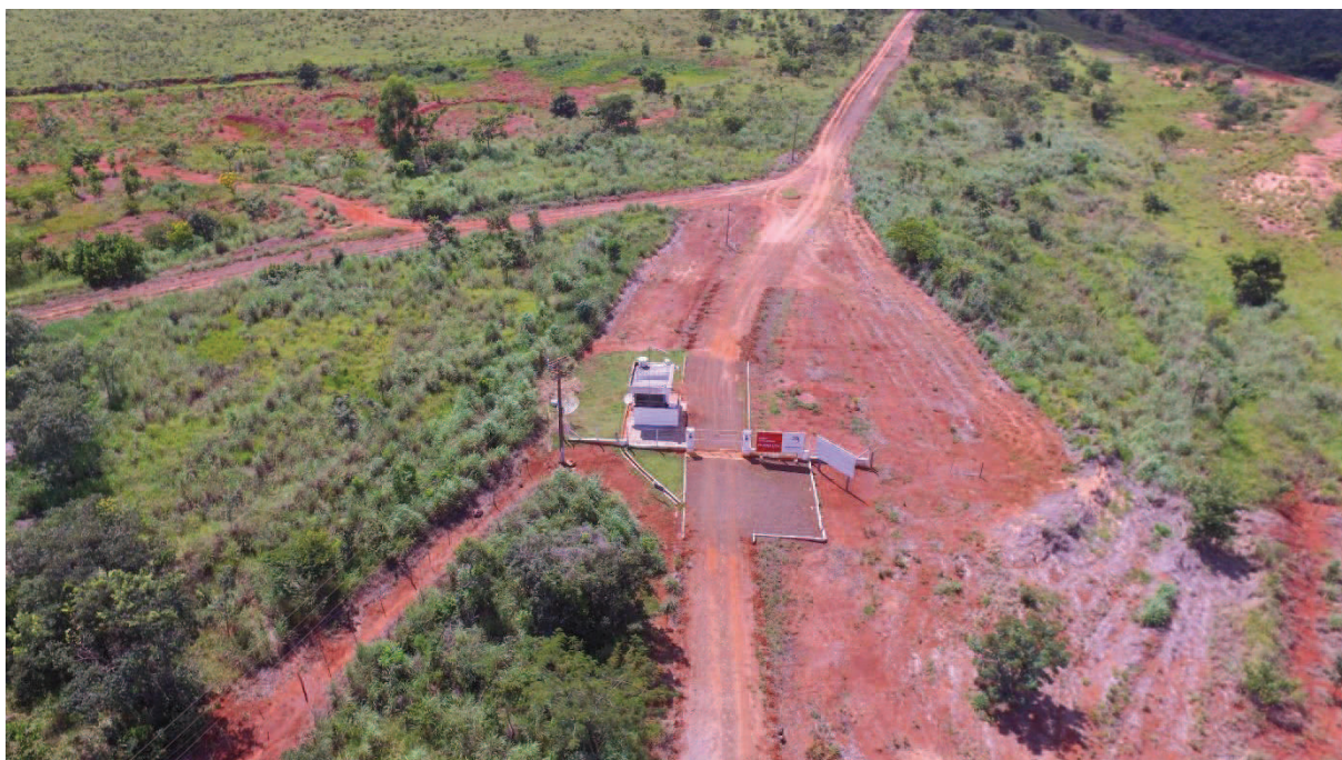
Figura 5 – Portaria de entrada da PCH Planalto
