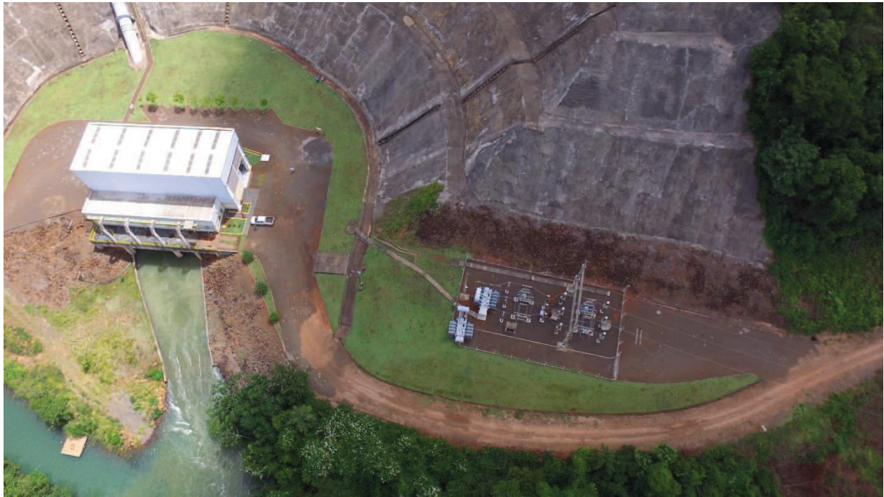
Figura 33 – Subestação em boas condições
