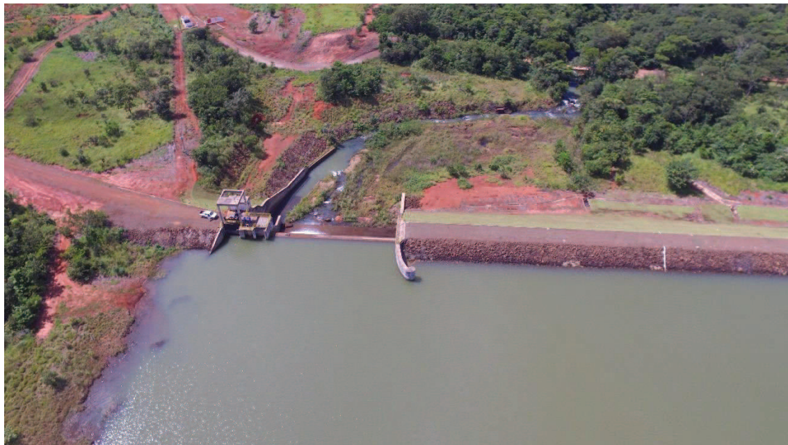
Figura 14 – Vista da calha de concreto do segundo trecho do vertedouro
