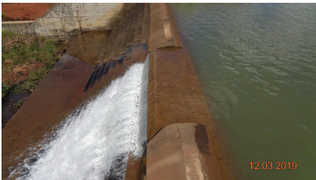
Figura 13 – Vista do primeiro trecho do vertedouro
