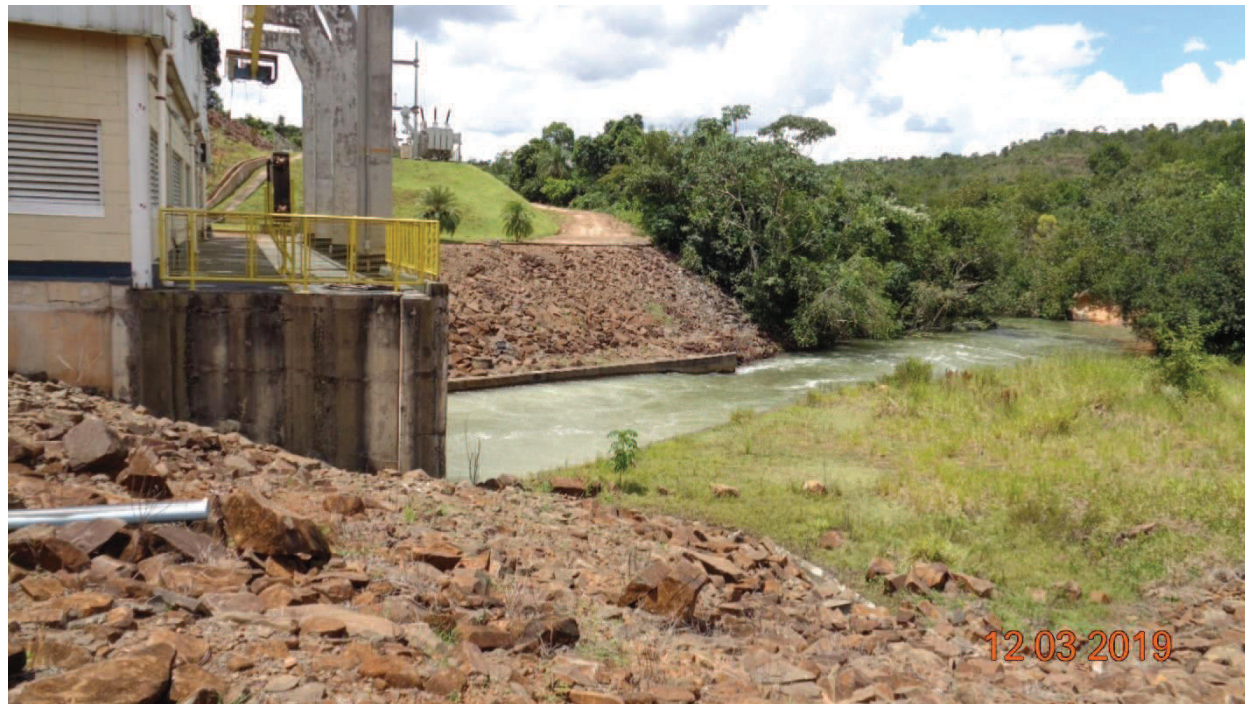
Figura 31 – Pântano de jusante da casa de força, canal de fuga e subestação ao fundo
