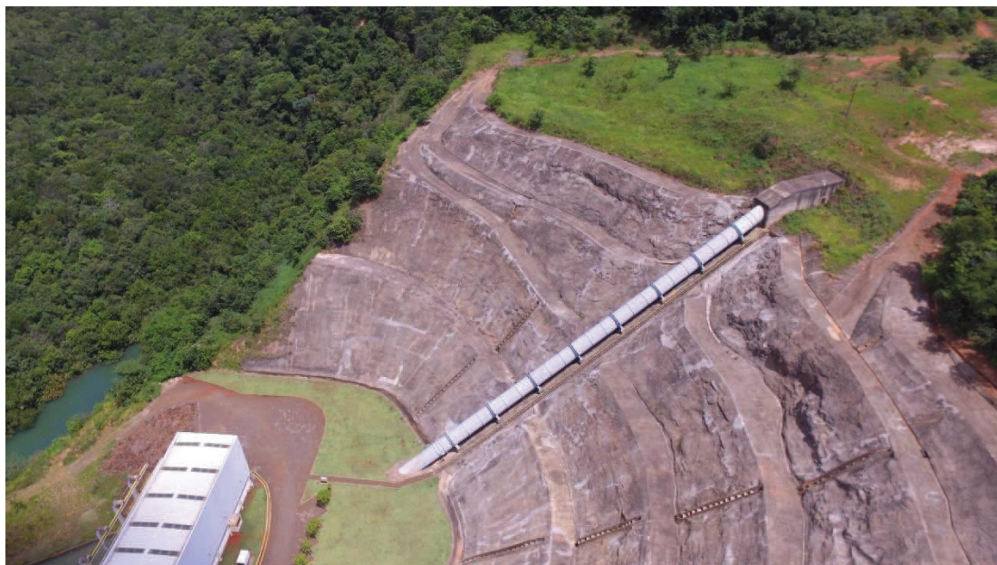
Figura 21 – Conduto Forçado trecho exposto
