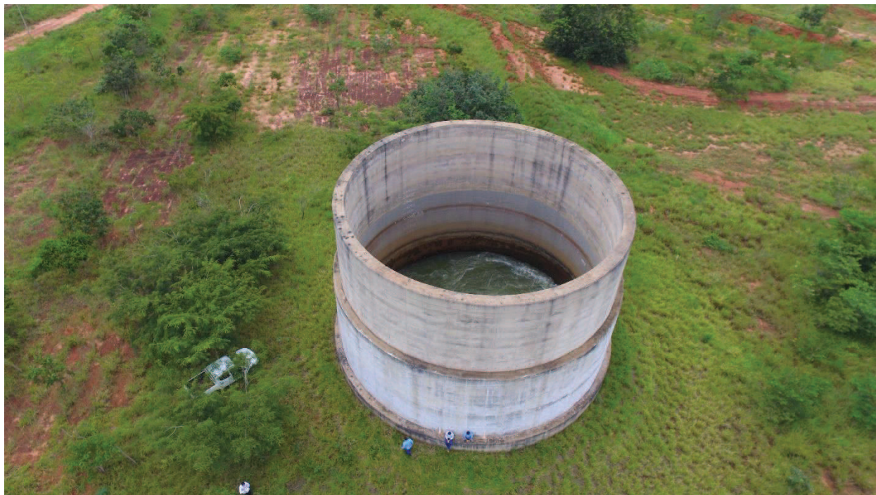
Figura 19 – Vista de Geral dos Conduitos Forçados
