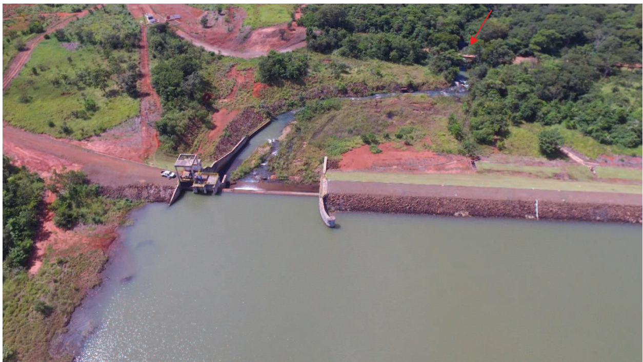
Figura 38 – Ponte Acesso Planalto - SL-88
