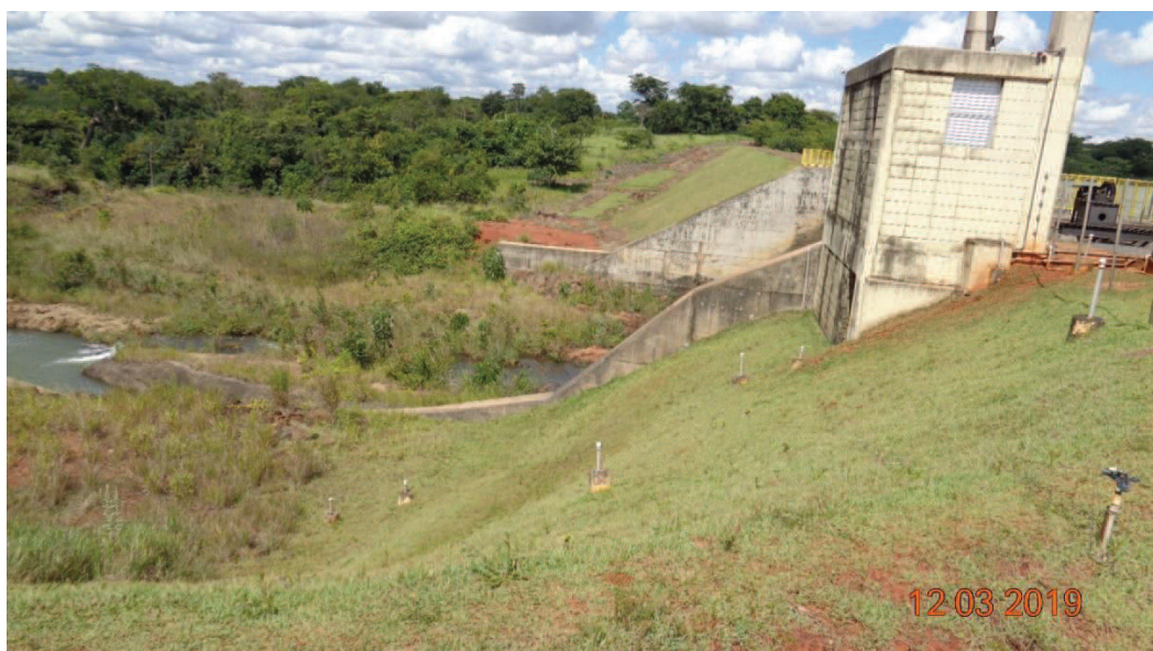
Figura 11 – Barragem margem esquerda com diversos piezômetros
