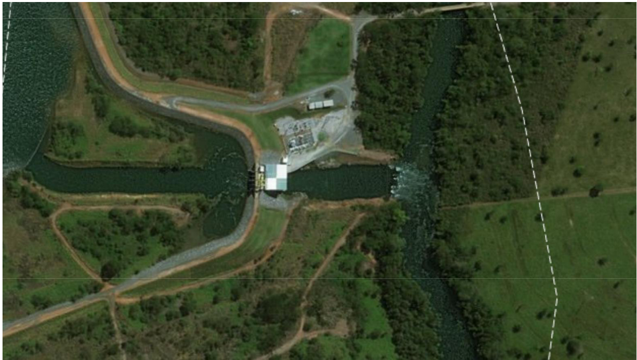
Figura 33 – Casa de Força PCH Salto - SL-136
