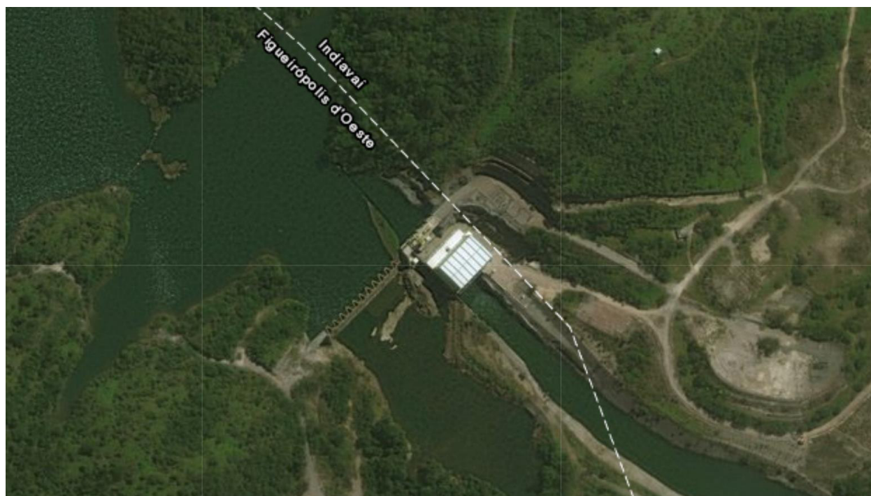
Figura 35 – Barragem PCH Figueirópolis - SL-69
