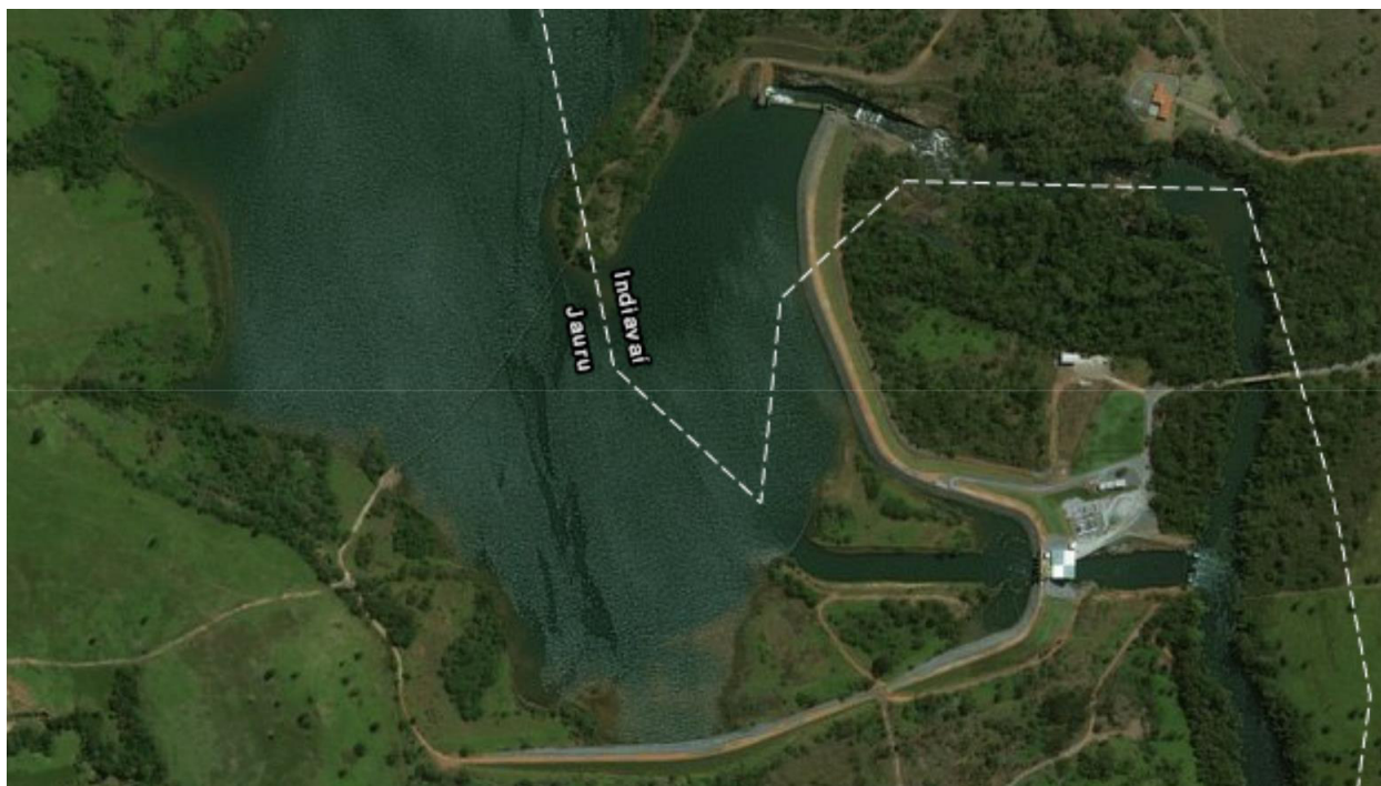
Figura 32 – Barragem PCH Salto - SL-139
