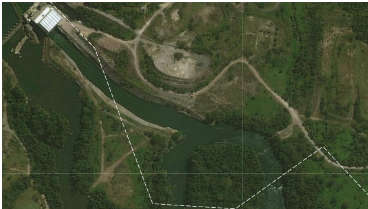
Figura 36 – Casa de Força PCH Figueirópolis - SL-66
