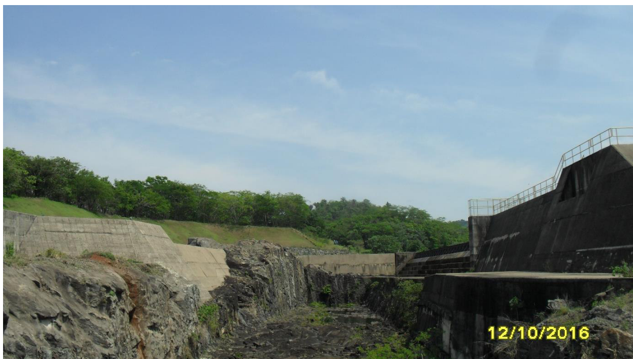
Figura 30 – Barragem/Vertedouro PCH Indiavaí - SL-154
