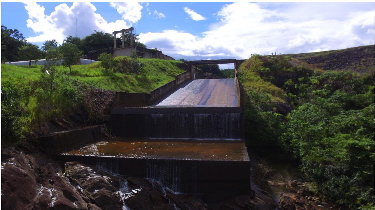
Figura 15 – Calha do Vertedouro, boas condições
