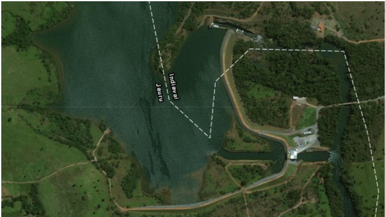
Figura 31 – Barragem PCH Salto - SL-139
