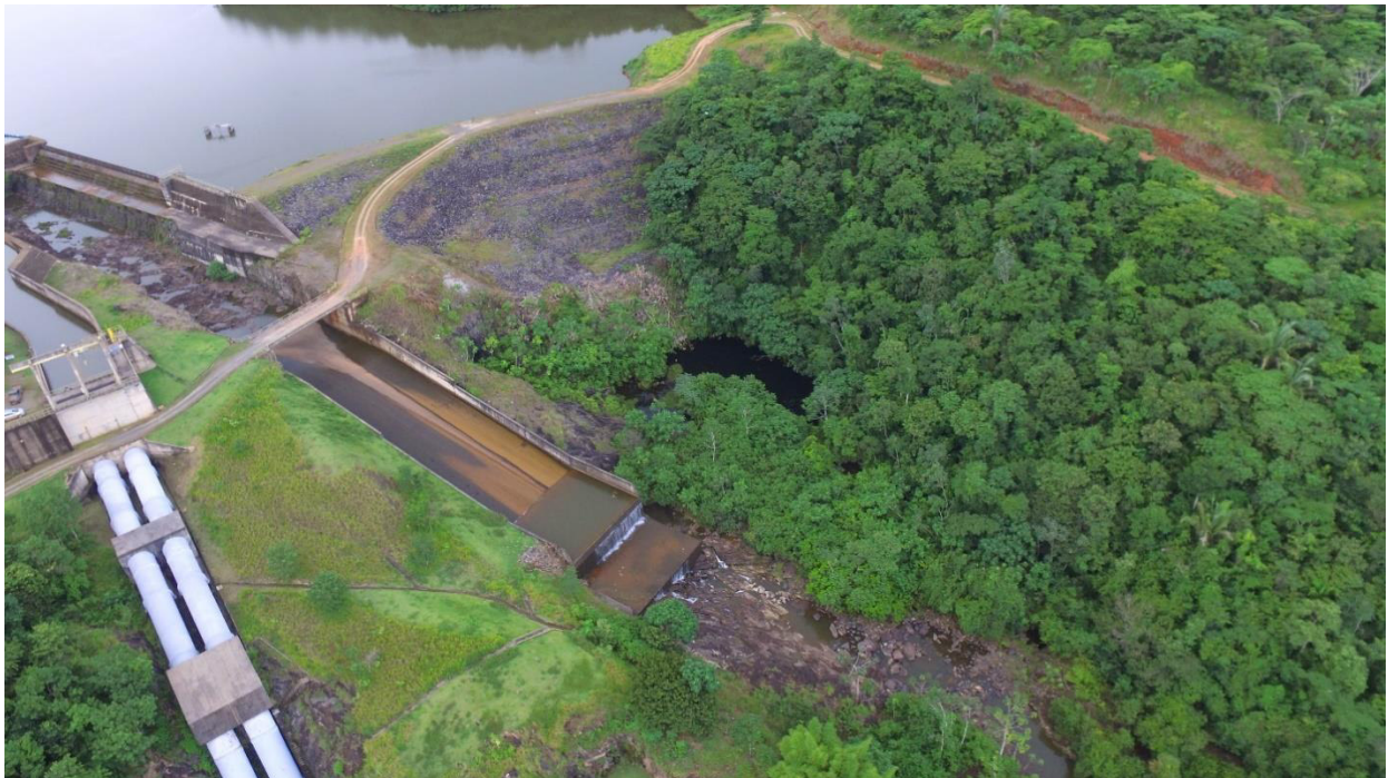
Figura 12 – Vista Geral da Barragem Ombreira Direita – Talude de jusante e crista
