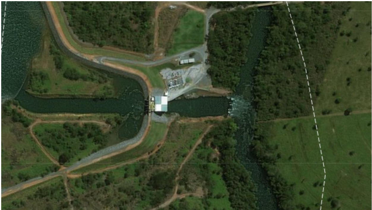
Figura 33 – Casa de Força PCH Salto - SL-136
