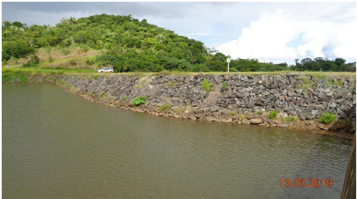
Figura 13 – Vista Geral da Barragem Ombreira Direita – Talude de montante
