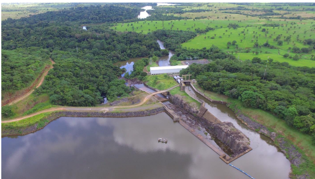
Figura 11 – Vista Geral Montante Usina
