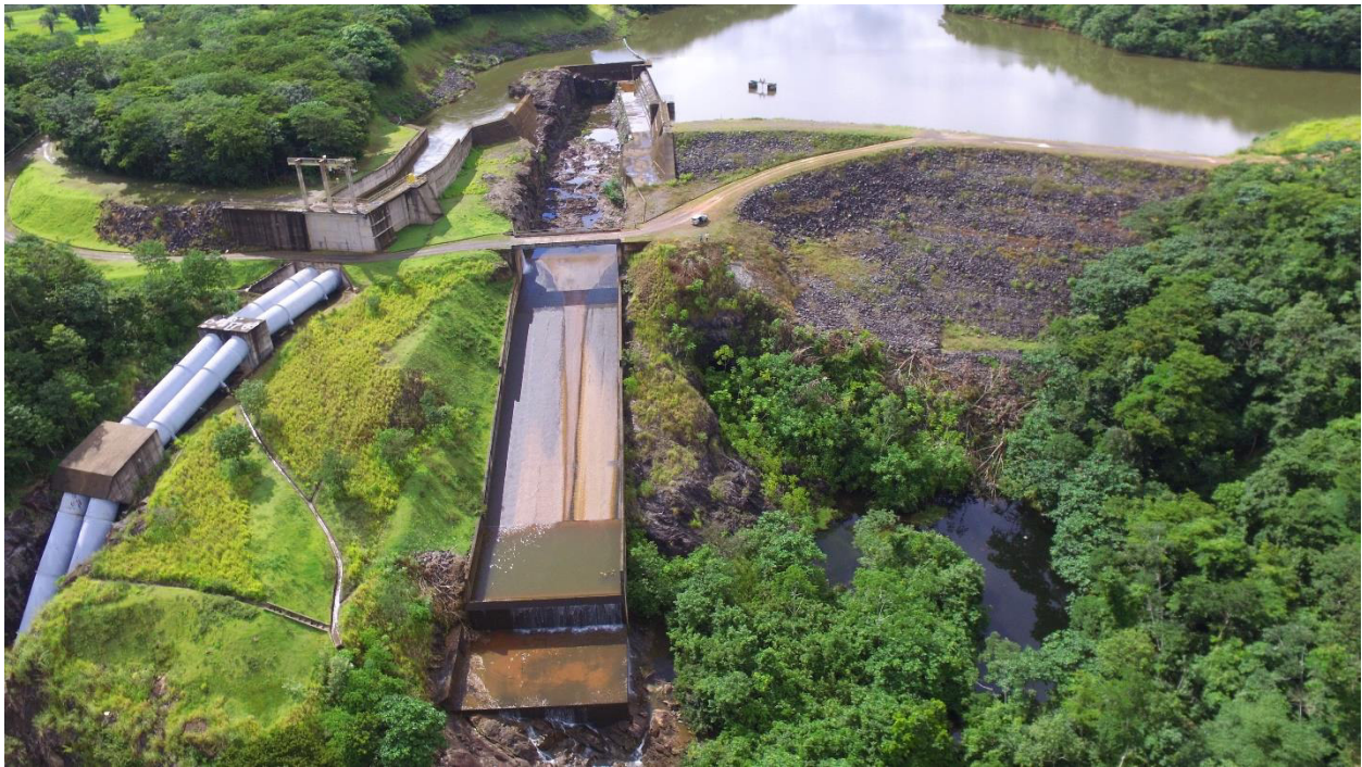
Figura 14 – Vista Geral do Vertedouro e margem esquerda da Barragem
