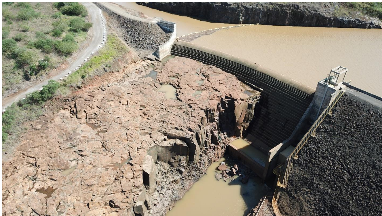
Figura 9 – Vertedouro da PCH Cantú 2
