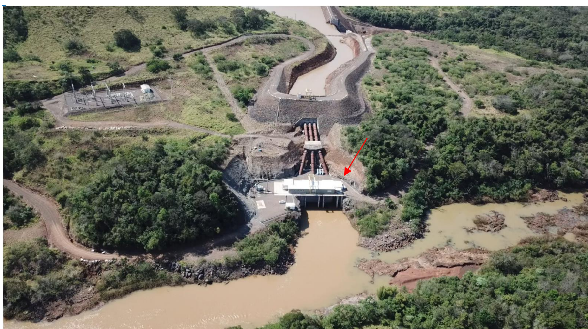
Figura 32 – Casa de Força da PCH Cantú 2
