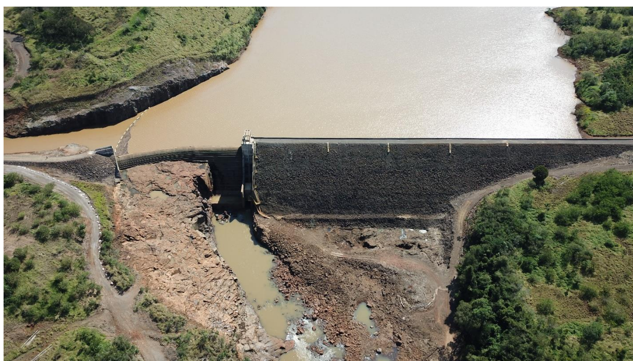
Figura 19 – Vista Geral do Barramento
