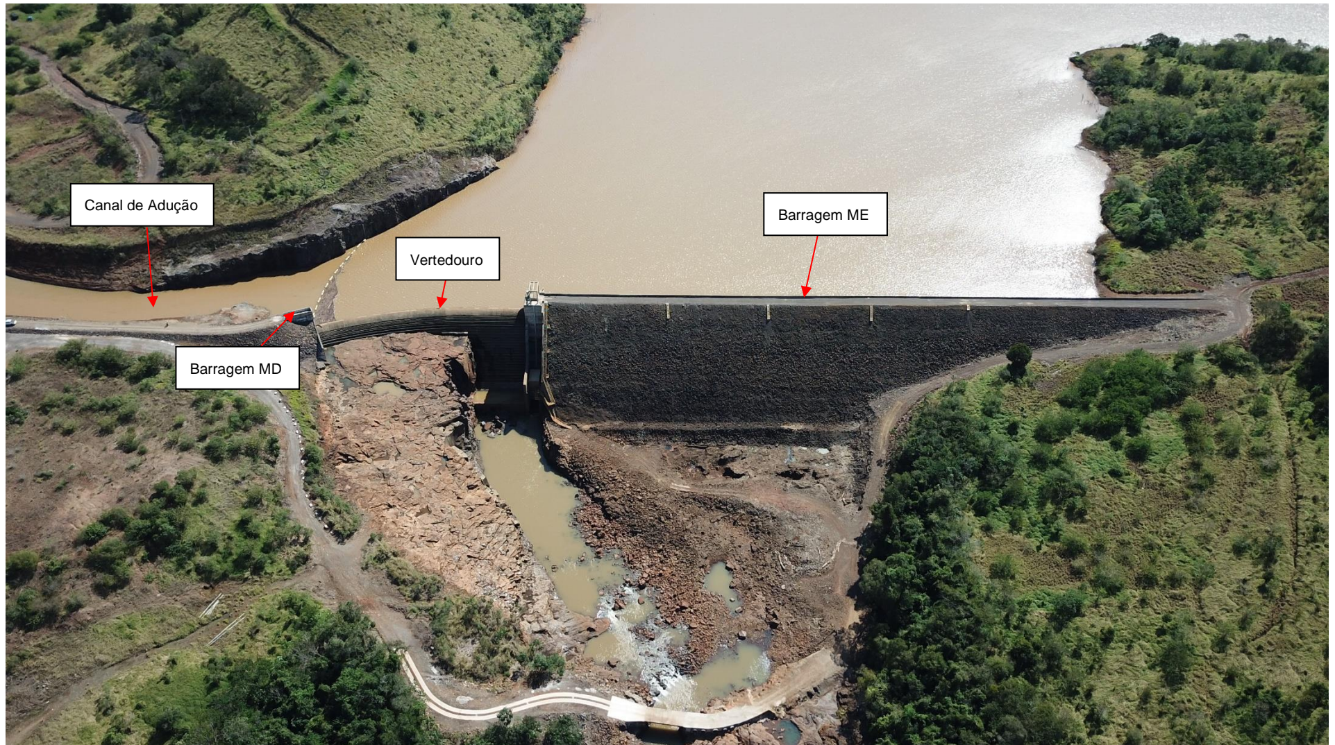
Figura 1 – Foto das estruturas civis da Montante – PCH Cantú 2
