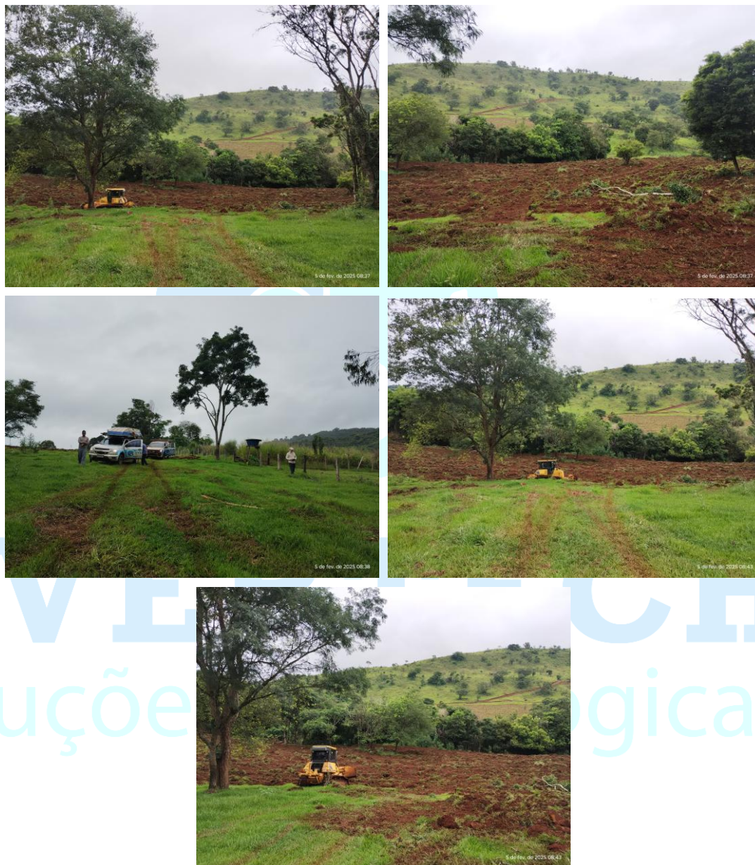
Figura 9 - Imagens obtidas durante os serviços na PCH Cantu 2 Montante 1
