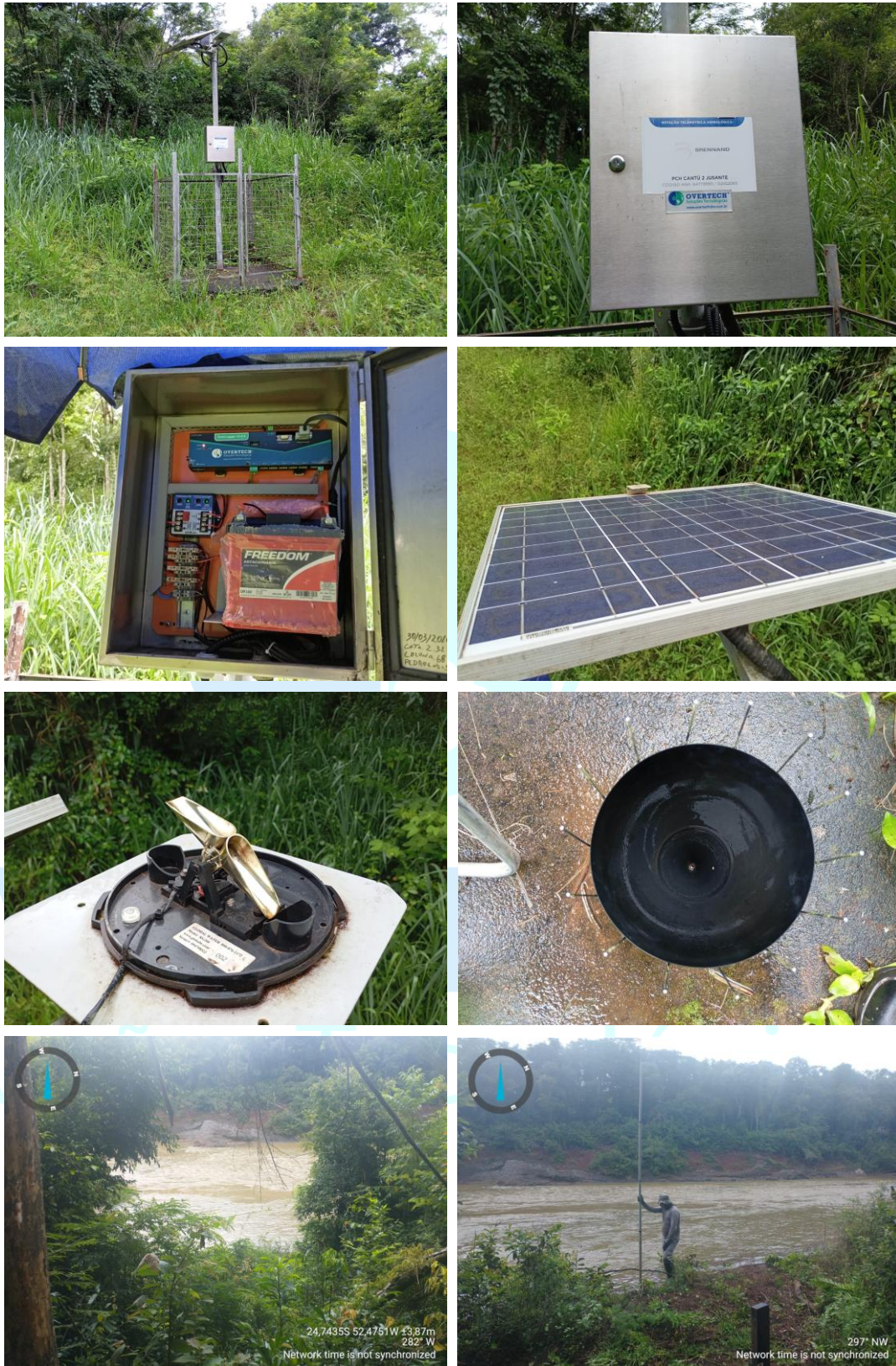
Figura 8 - Imagens obtidas durante os serviços de inspeção e limpeza da PCD em PCH Cantu 2 Jusante.
