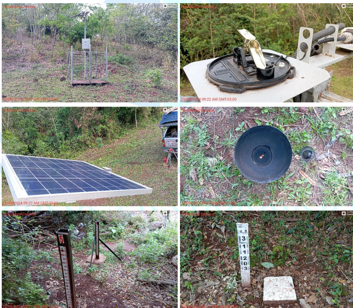
Figura 2 - Imagens obtidas durante os serviços de Inspeção e limpeza da PCD em PCH Cantu 2 Jusante.
