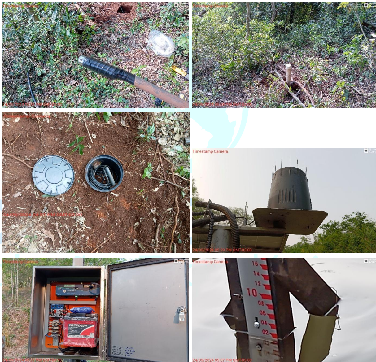
Figura 4 - Imagens obtidas durante os serviços de Inspeção e limpeza da PCD em PCH Cantu 2 Jusante.
