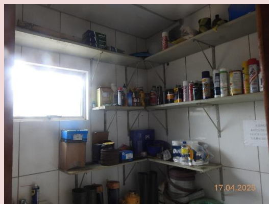
Foto 5-14. Vista de uma das prateleiras próximas de uma das Unidades Geradoras (UG2) da PCH.
