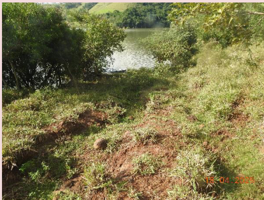
Foto 5-9. Vista parcial da erosão do tipo sulco evidenciando a cobertura por gramíneas.
