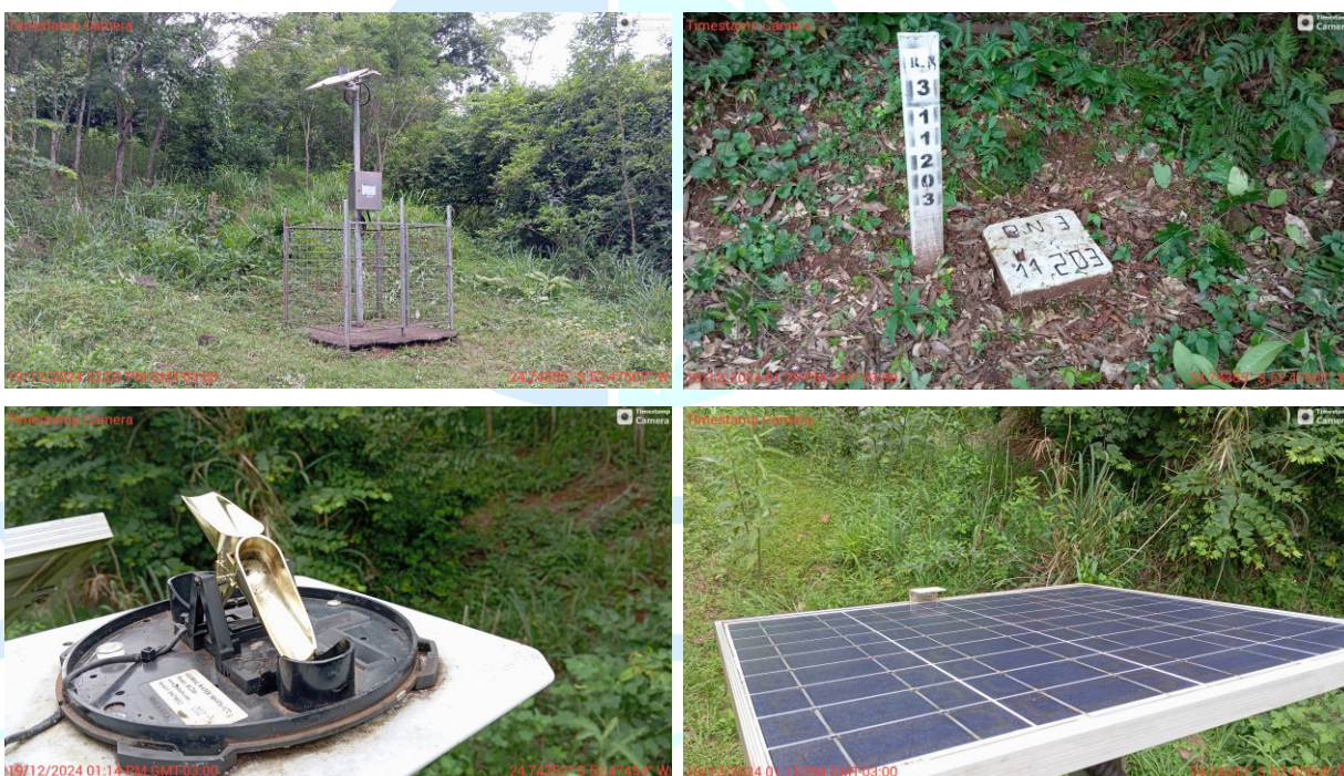
Figura 2 - Imagens obtidas durante os serviços de Inspeção e limpeza da PCD em PCH Cantu 2 Jusante.
