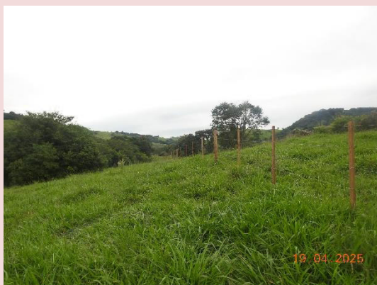
Foto 5-21. Vista do cercamento reparado na margem esquerda do reservatório, abrangendo um longo trecho de cerca erguida.
