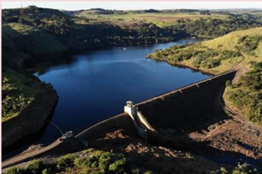
Foto 5-23. Vista aérea do Barramento da PCH Cantú 2, Rio Cantú, Paraná.
