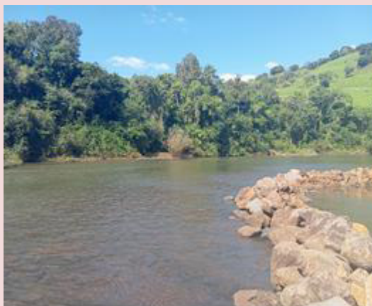
Foto 4-4. Aspecto geral do ponto Jusante (JUS).
