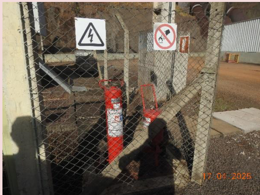
Foto 5-7. Disposição de extintores na área externa da casa de força da PCH Cantú 2.
