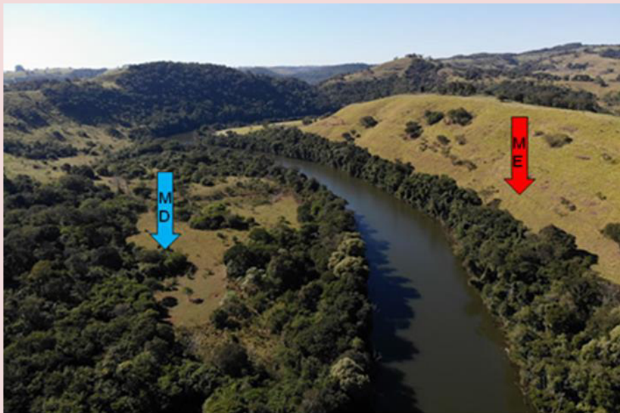
Foto 5-24. Vista panorâmica das margens direita (MD) e esquerda (ME) de um dos trechos do Rio Cantú, Paraná.
