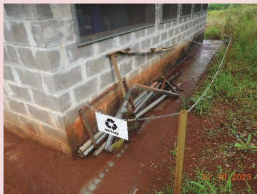
Foto 5-16. Área na parte externa do compartimento para transbordo final destinada para descarte temporário de metais.
