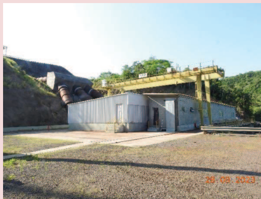
Foto 5-2. Vista aproximada da casa de força da PCH Cantú 2.
