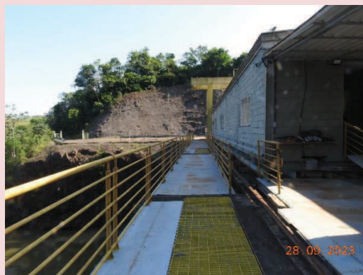
Foto 5-6. Vista externa da casa de Força da PCH Cantú 2.
