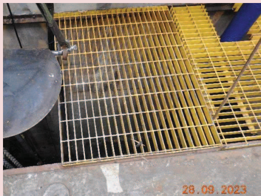
Foto 5-29. Grade com acesso para a caixa SAO na área interna da casa de força da PCH Cantú 2.
