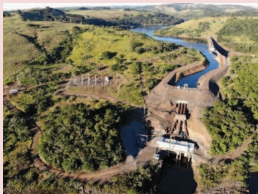
Foto 5-1. Vista aérea da casa de força e da alça de vazão reduzida da PCH Cantú 2.
