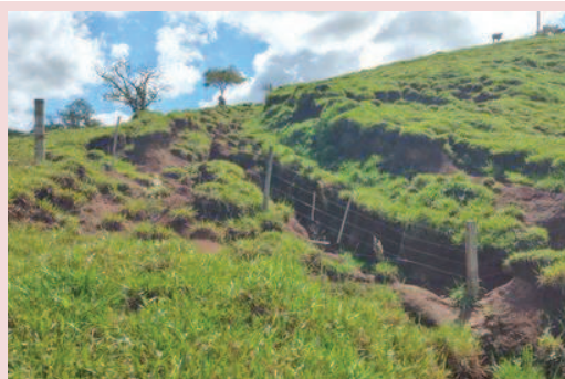
Foto 5-12. Vista aproximada e em terra do processo erosivo em estrada abandonada no Sítio Santa Rita, margem direita do rio Cantú.
