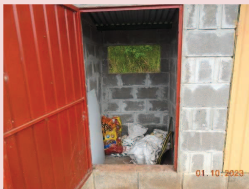
Foto 5-20. Vista interna de um dos compartimentos (Plástico).
