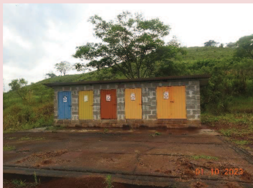
Foto 5-15. Compartimentos para transbordo final de resíduos das classes I e II.
