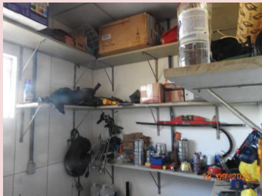
Foto 5-27. Vista de uma das prateleiras próximas de uma das Unidades Geradoras (UG2) da PCH.
