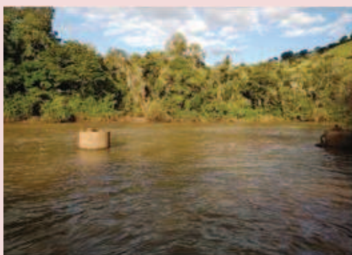
Foto 4-4. Aspecto geral do ponto Jusante (JUS).
