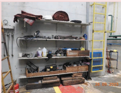
Foto 5-26. Vista de uma das prateleiras próximas de uma das Unidades Geradoras (UG2) da PCH.
