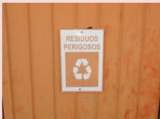
Foto 5-23. Vista da porta do compartimento de Resíduos Perigosos na área de transbordo final da PCH Cantú 2.
