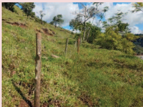
Foto 6-11. Vista de cercamento instalado em área de APP na margem esquerda do reservatório.
