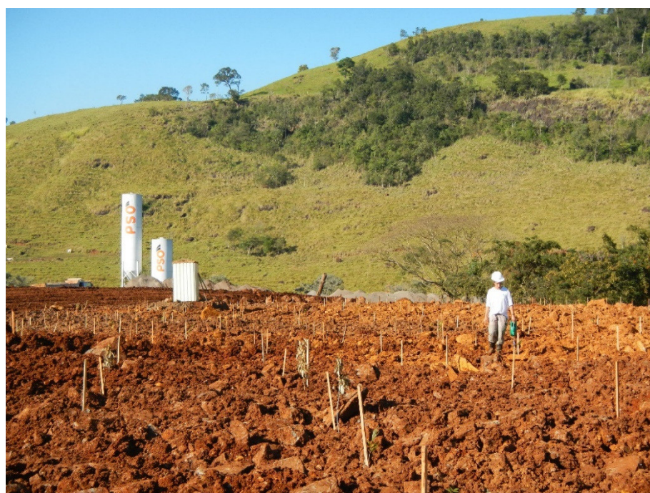
Figura 20: Processo de umidificação das mudas plantadas, com auxílio da mangueira do caminhão pipa e regadores SOMA.
