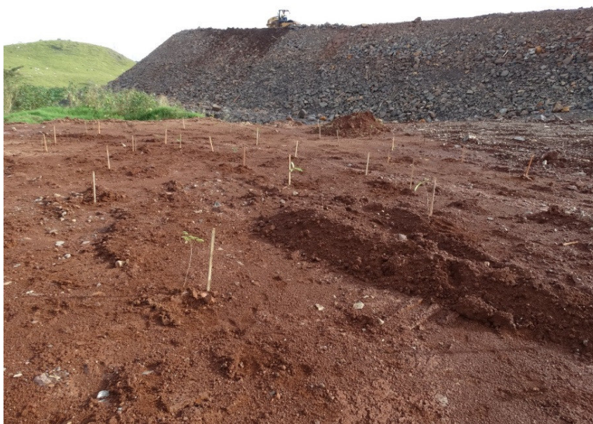
Figura 13: 5ª área de plantio do Canteiro de Obras PCH CANTU 2 com poucos tutores alocados.
