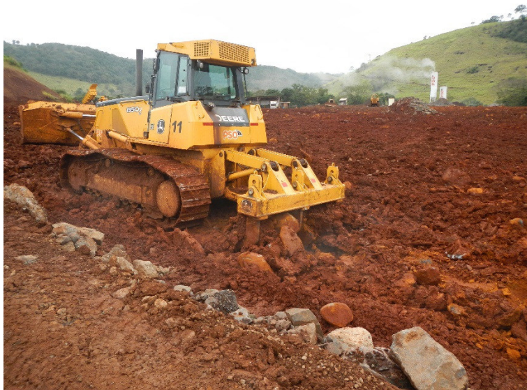
Figura 17: Escarificador PSO trabalhando na 6ª área de plantio. Detalhe para rochas na área.
