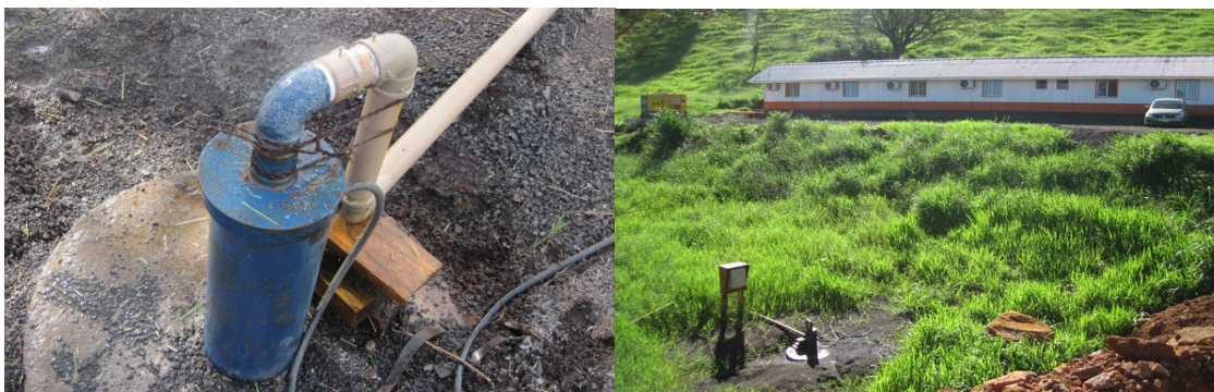
Figura 1.7 – Poço 02 no canteiro de obras da PCH Cantu 2.
