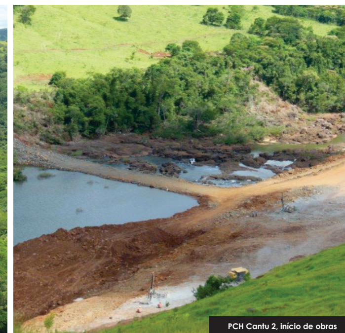
PCH Cantu 2, início de obras
