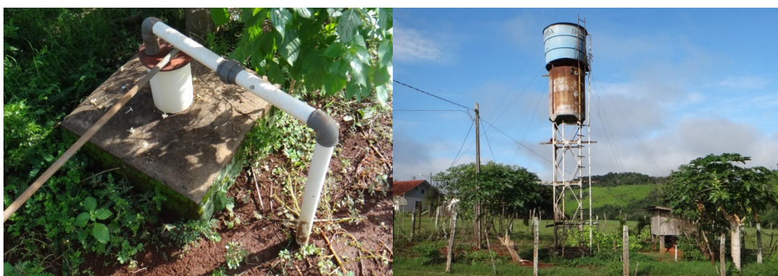
Figura 1.6 – Poço 01 no local de montante e caixa para onde a água é bombeada.
