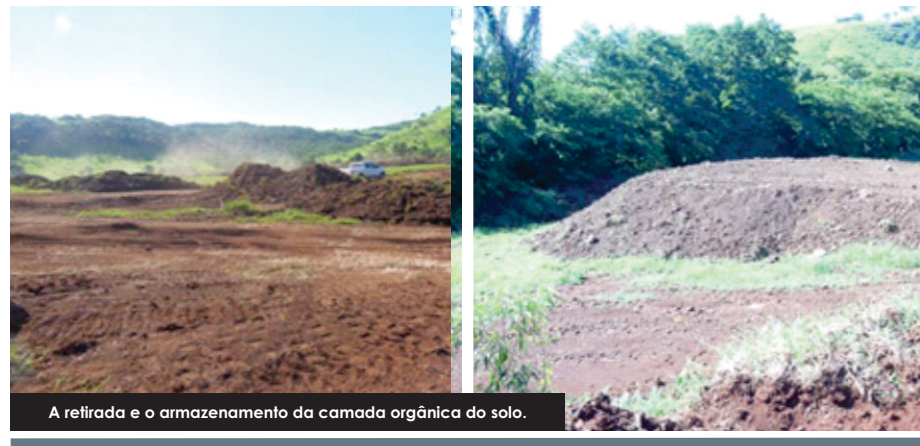
Supressão florestal e movimentação de terra/escavações após demarcação em campo das áreas necessárias à construção do barramento e estruturas associadas
