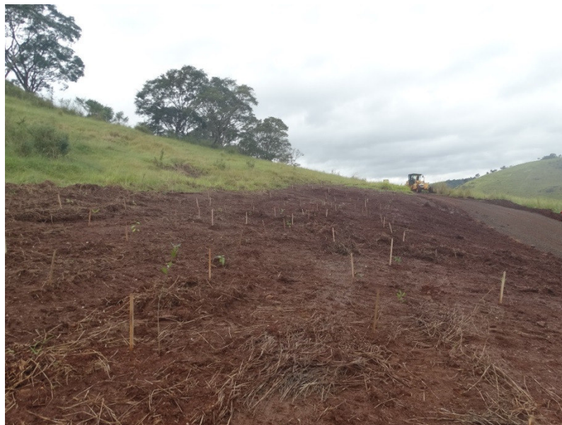
Figura 7: Visão panorâmica da 2ª área plantada no Canteiro de Obras PCH CANTU 2. Em destaque para retirada da camada vegetal e os tutores alocados esparsamente.
