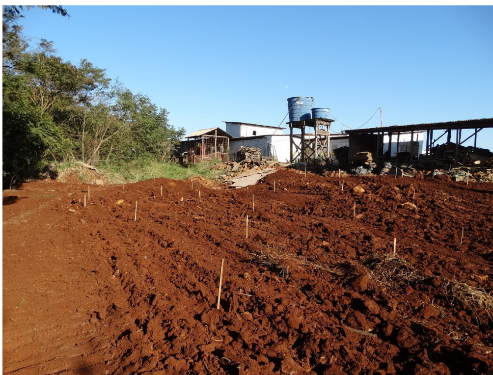
Figura 26: Área 9 de plantio do canteiro de obras PCH CANTU 2.
