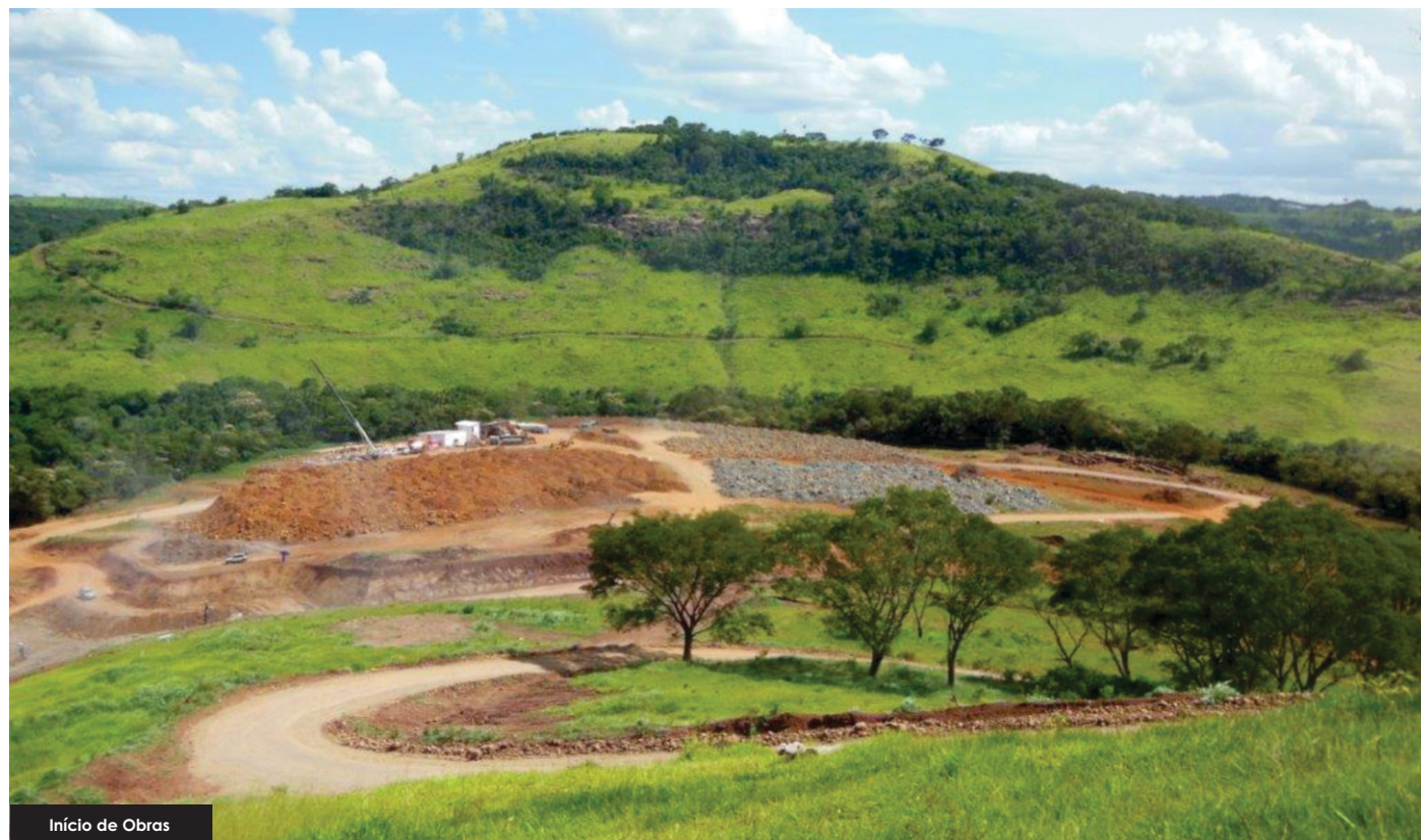
Início de Obras
