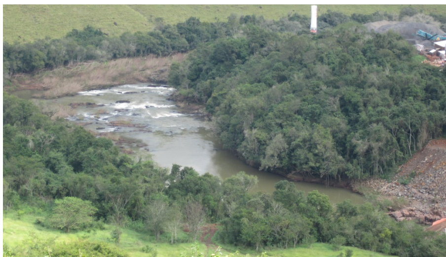
Figura 3.4.4 – Vista panorâmica do local de amostragem Trecho de Vazão Reduzida, na área de influência da futura PCH Cantu 2, rio Cantu.
