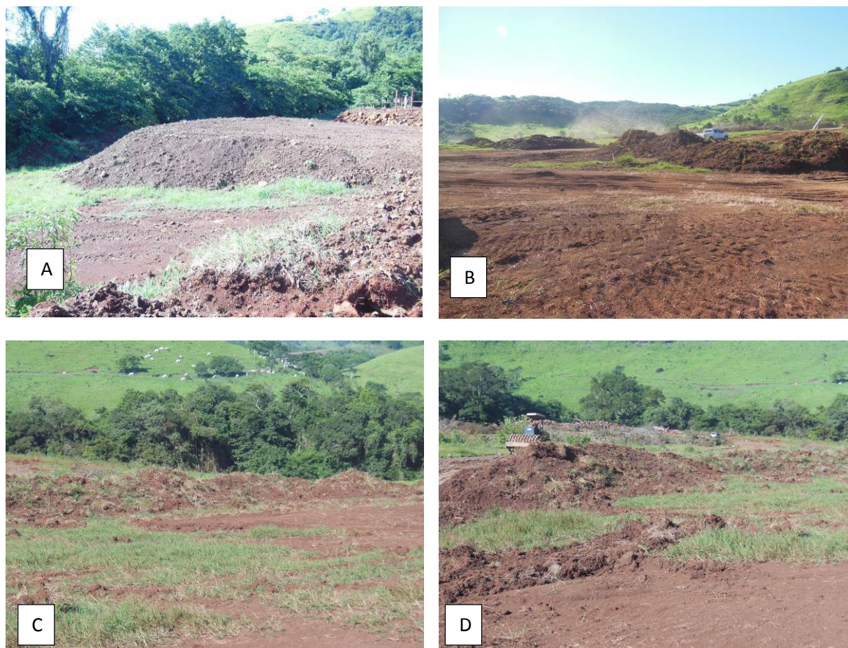
Figura 3.2.1 (A-B-C-D) – Armazenamento da camada orgânica do solo após decapeamento do solo.
