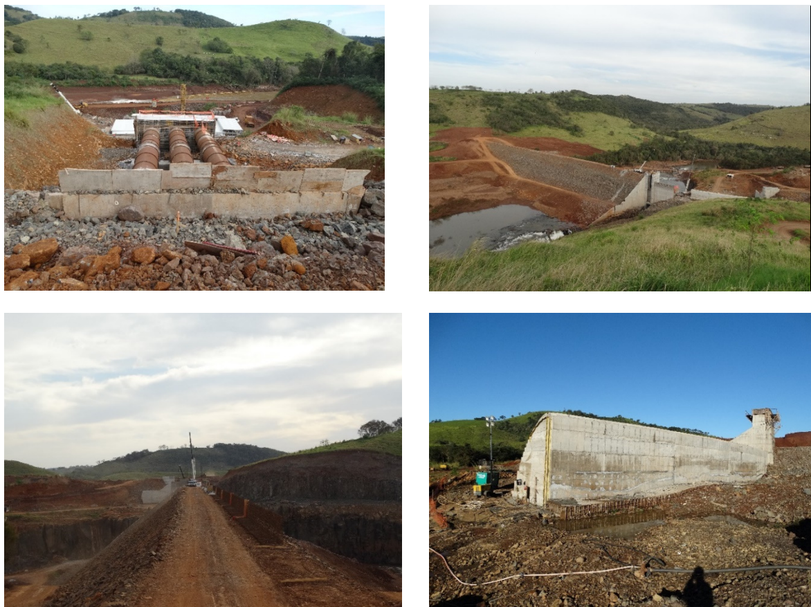
Figura 3.18.1 (A,B,C,D,E,F,G,H,I,J,L,M,N e O) - Acompanhamento das frentes de trabalho
