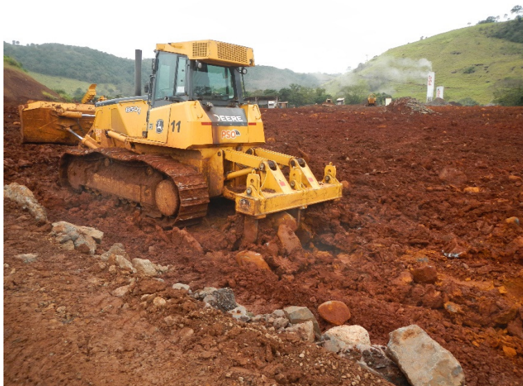
Figura 3.2.18 - Escarificador trabalhando na 6ª área de plantio. Detalhe para rochas na área.
