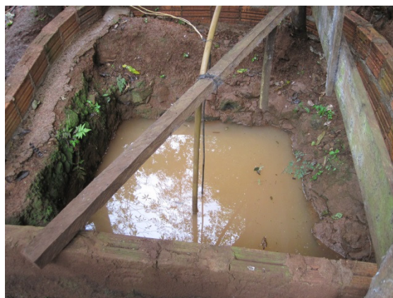
Figura 3.3.3 e 3.3.4 – Poço caçimba na propriedade do João Maria Subetil, que possibilita a medição do lençol.
