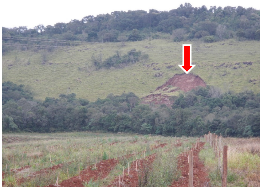
Figura 3.2.1.4 – Julho/15 - erosão em Fazenda Burro Branco (Margem Esquerda do barramento – Montante-Jusante) avistada em Propriedade de Fernando Mariot (Margem Direita).
