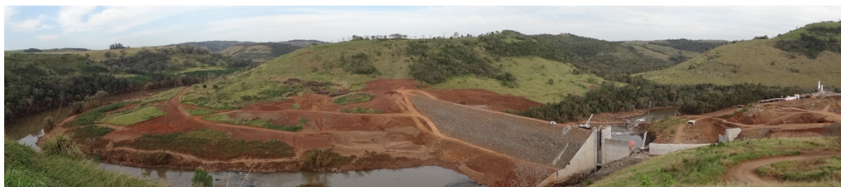
Figura 3.18.3 – Vista do mirante localizado dentro do canteiro de obras da PCH CANTU 2.
