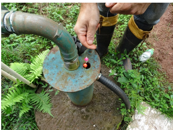
Figura 3.3.6 – Adaptação de linha com chumbadas e “bóinhas” para aferição de lençol freático.
