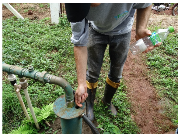
Figura 3.3.5 – Poço 03, localizado em Assentamento Chapadão.
