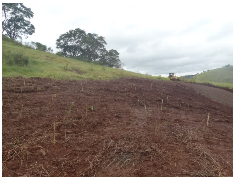
Figura 3.2.16 - Visão panorâmica da 2ª área plantada no Canteiro de Obras PCH CANTU 2. Em destaque para retirada da camada vegetal e os tutores alocados esparsamente.
