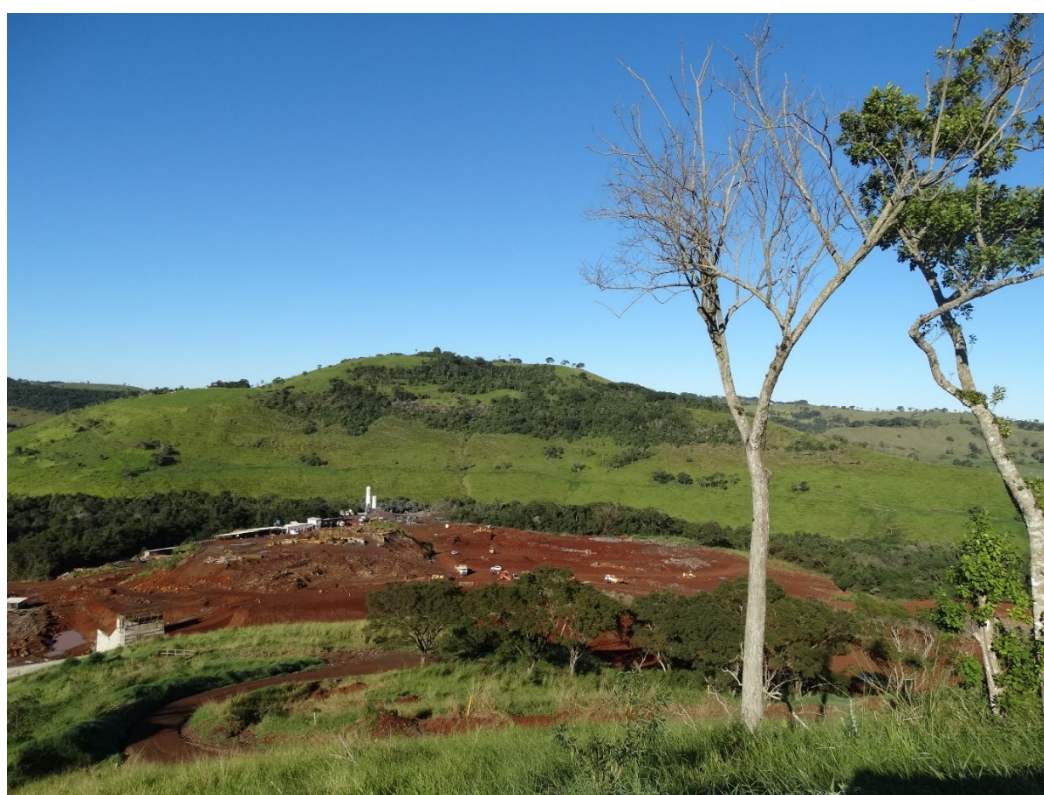
Figura 3.18.4 – Vista do mirante localizado no canteiro de obras da PCH CANTU 2.
