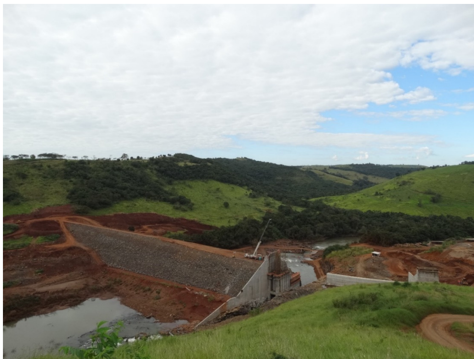
Figura 3.18.2 – Vista do mirante localizado dentro do canteiro de obras da PCH CANTU 2.
