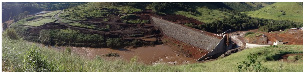
Figura 3.18.5 – Vista do mirante localizado no canteiro de obras da PCH CANTU 2.
