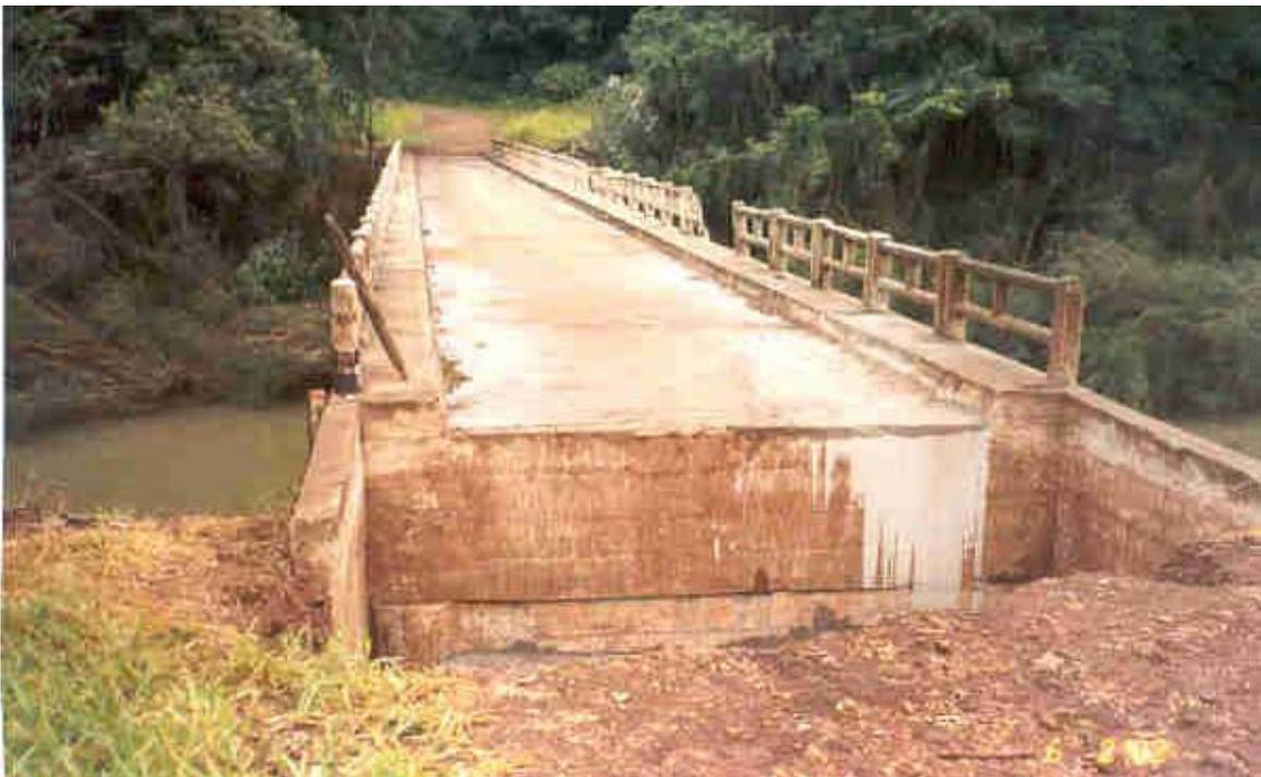
Figura 4.3.7.1 - Ponte interrompida na estrada entre Roncador e Palmital. Posteriormente este acesso foi refeito.
